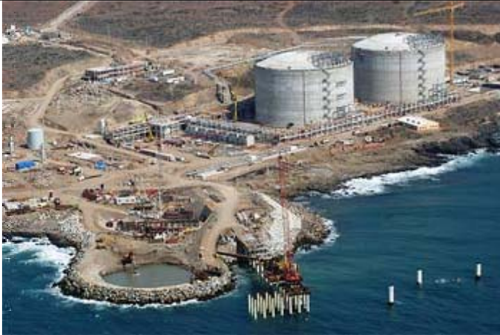
Ilustración 1.8 Estanque de almacenamiento.
