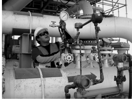
Ilustración 1.10 Línea de tubería.
