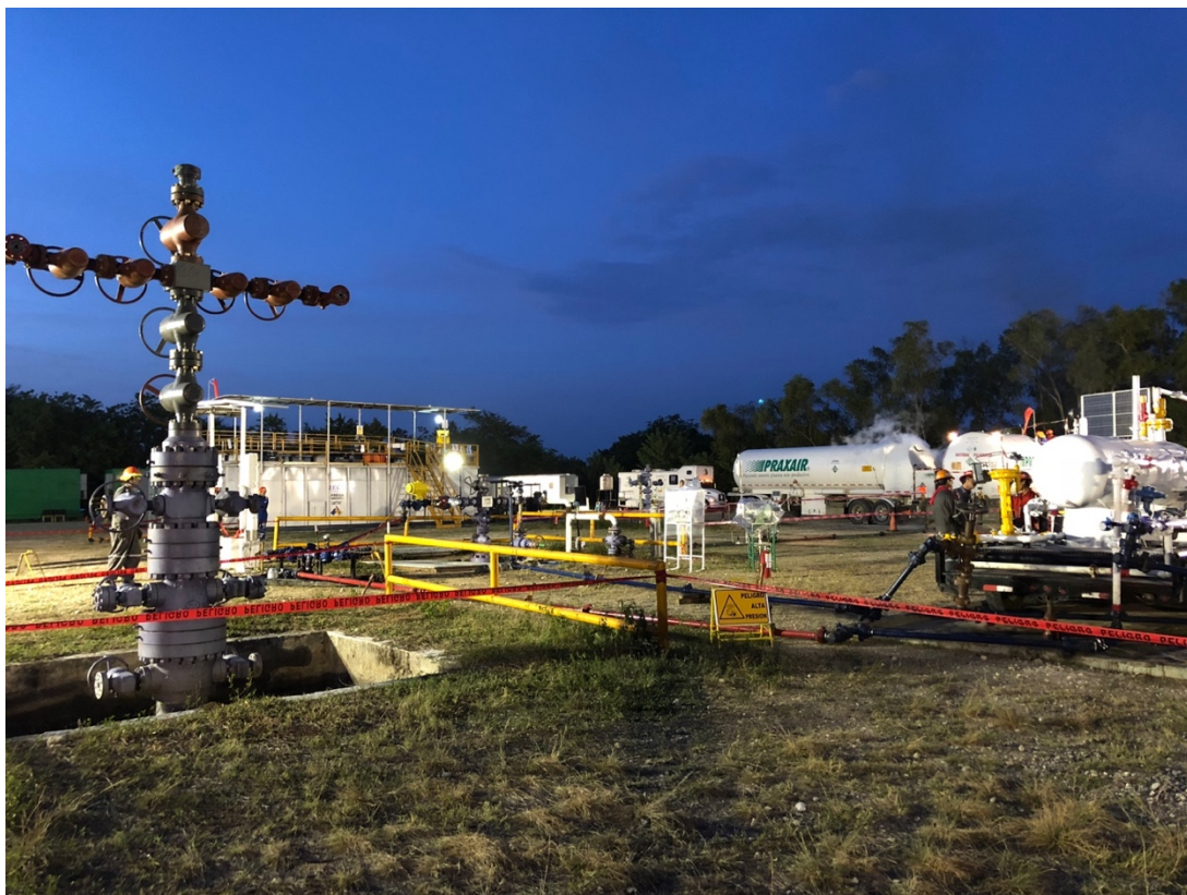
Figura 4.3 Fotografía de prueba de trazadores realizada en Villahermosa, (se observa al centro de la imagen, la bomba de inyección de trazadores radiactivos).
