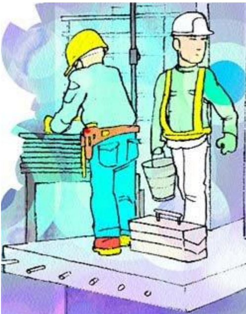
Figura 20 Obstrucción de pasillo
