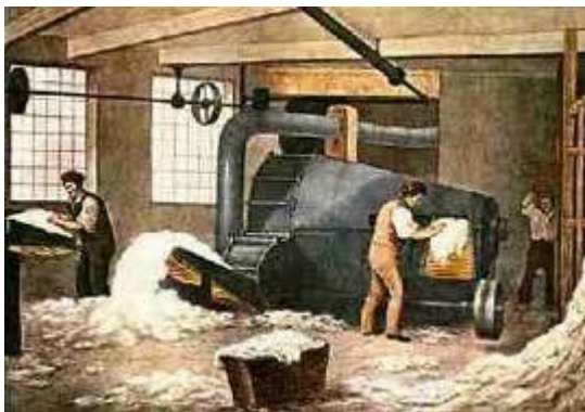
Figura 23 Ejemplo de mala ventilación en la industria
