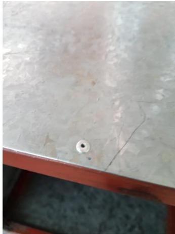
*Figura 5.6 Sujeción de lámina a armazón*
