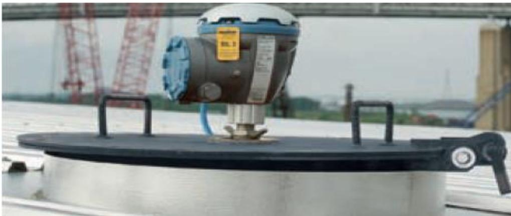
*Figura 46. Medidor de Nivel por radar en un tanque de almacenamiento de techo fijo (Emerson, 2017 “Guía de Medición en Tanques de Almacenamiento”)*
