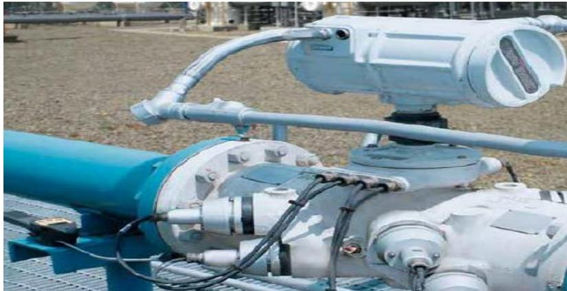
Figura 74. Ejemplo de Medidor Ultrasónico (CENAM, 2006 "Medidores Ultrasónicos")
