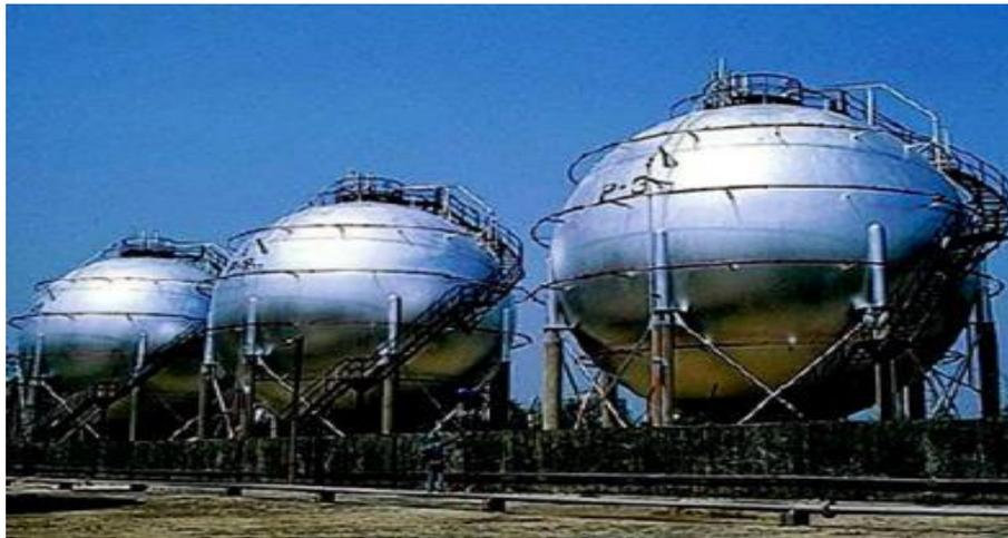
Figura 47. Tanques esféricos para el almacenamiento de gas (Emerson, 2017 "Guía de Medición en Tanques de Almacenamiento")
