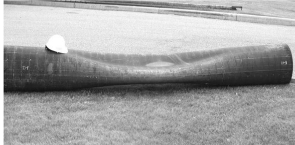
Figura II. 6.- Imagen de un ducto colapsado bajo presión externa, (Kyriakides y Corona, 2007).
