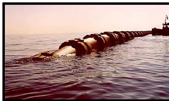
Figura I.6.- Proceso de una forma de inmersión del ducto (Ribeiro, 2008).
