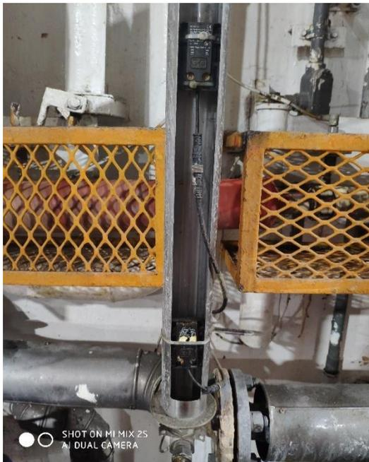
Figura 4.2 Mirilla de vidrio con sensores capacitivos.
