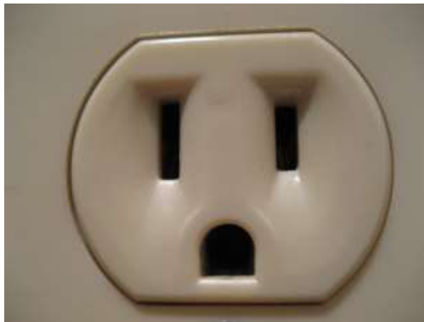
FIGURA 33 Contacto con terminal de puesta a tierra
