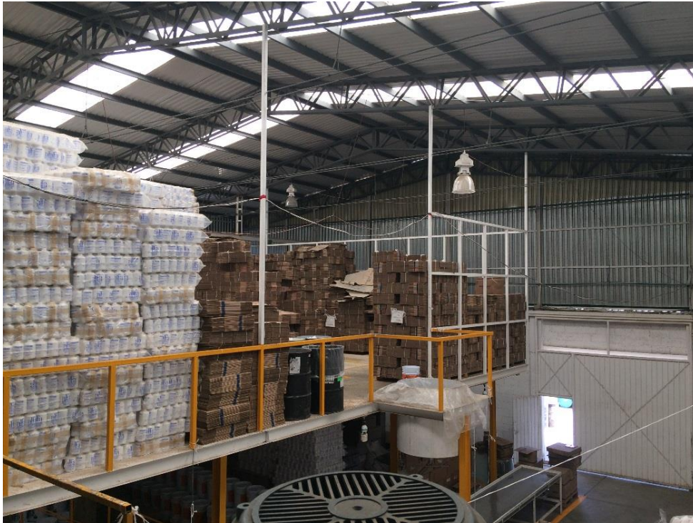
Figura 3.2 Nave “A” Almacén
