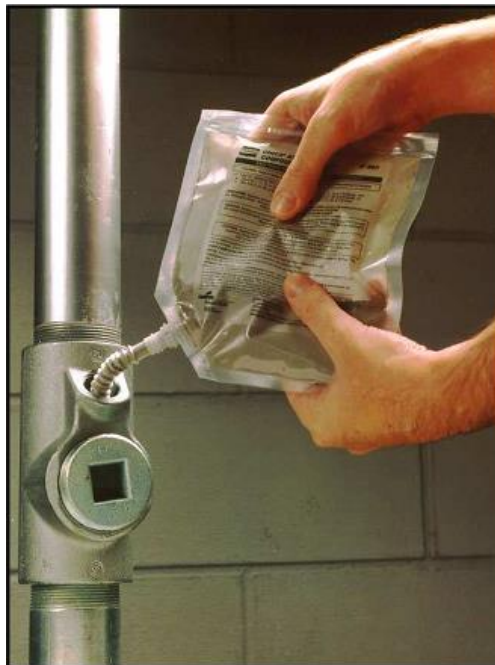
Figura 2.39 Aplicación de compuesto sellador. (Cortesía de Crouse-Hinds)
