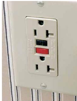
Figura 2.9 Contacto dúplex con protección de falla a tierra. En National Electric Code Handbook (p.65) Mark W. Earley 2014
