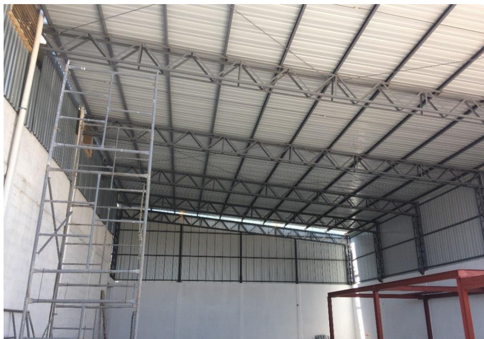
Figura 3.4 Nave “C” En proceso de construcción
