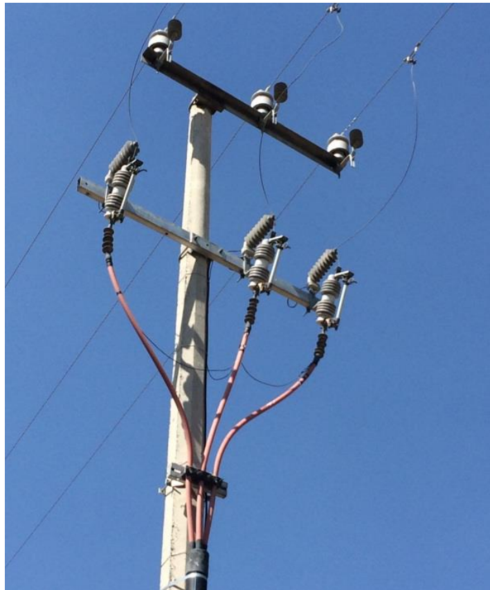
Figura 3.5 Punto de conexión con la CFE
