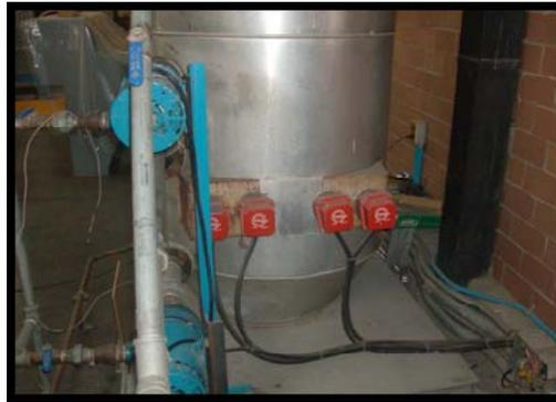
Figura 1.10. Banco de resistencias para calentamiento del agua.
