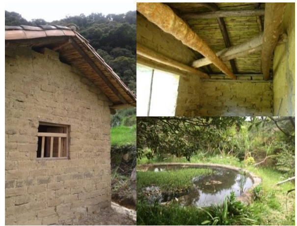
Figura 10. Casas construidas en adobe, resultado del taller de bio-construcción. Tomadas por Lyda y TURISTIVA
