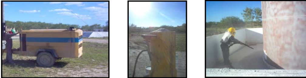
Equipo de sand-blast en funcionamiento.
