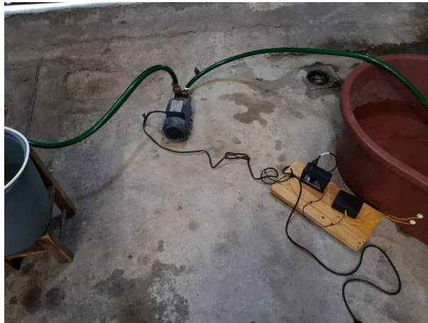
Figura 67 Instalación de gabinetes utilizados en "Cisterna".
