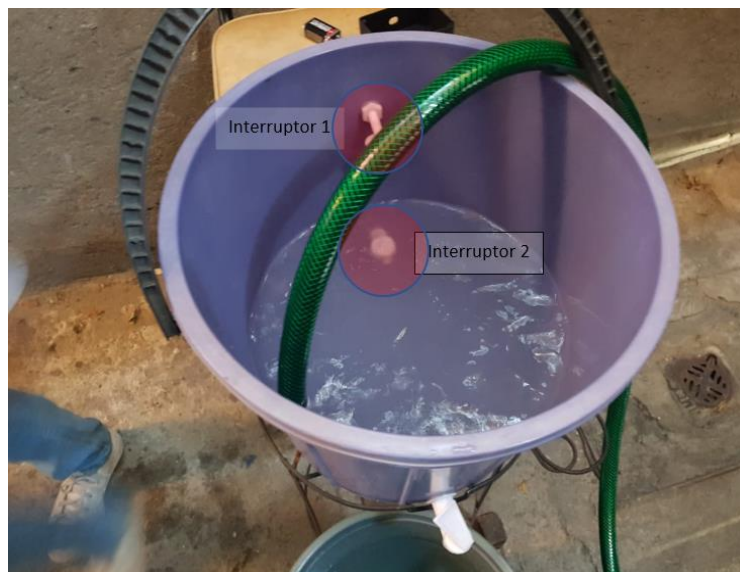
Figura 57 Implementación de interruptores de nivel de agua a un recipiente "Tinaco".
