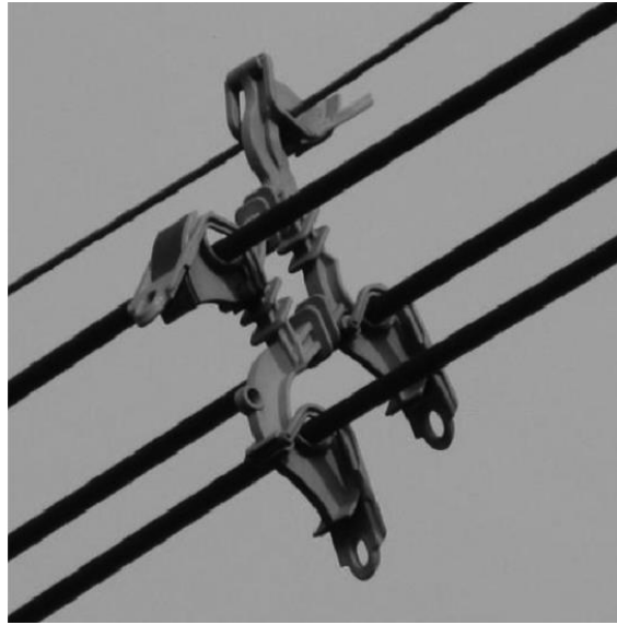
Figura 1.7. Sistemas de conductores cubiertos con espaciadores. [3]
