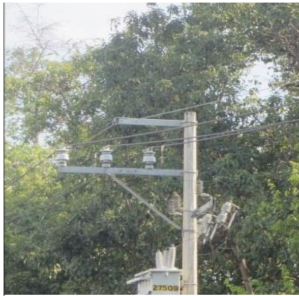
Figura 1.6. Sistema de conductores cubiertos y aisladores tipo alfiler. [1]
