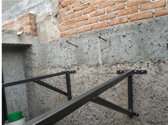
Figura 70: Instalación de las ménsulas a la altura deseada para las pruebas.
