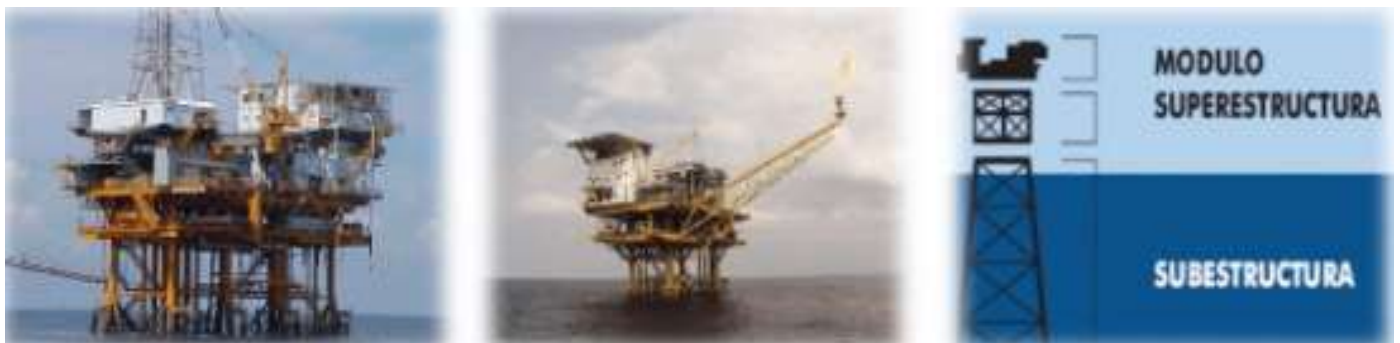
Figura 32. Plataforma fija de perforación.
