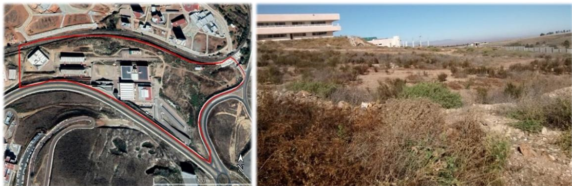
Figura 15. Zona UPIIZ: vista aérea y a nivel del suelo.
