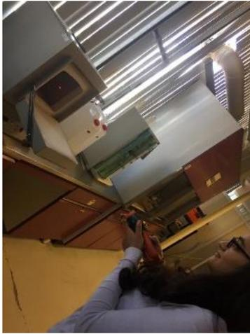
*Imagen 62. Toma de temperatura con un termo*
