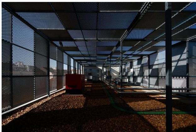
*Ilustración 39 Bastidor con rejilla*
