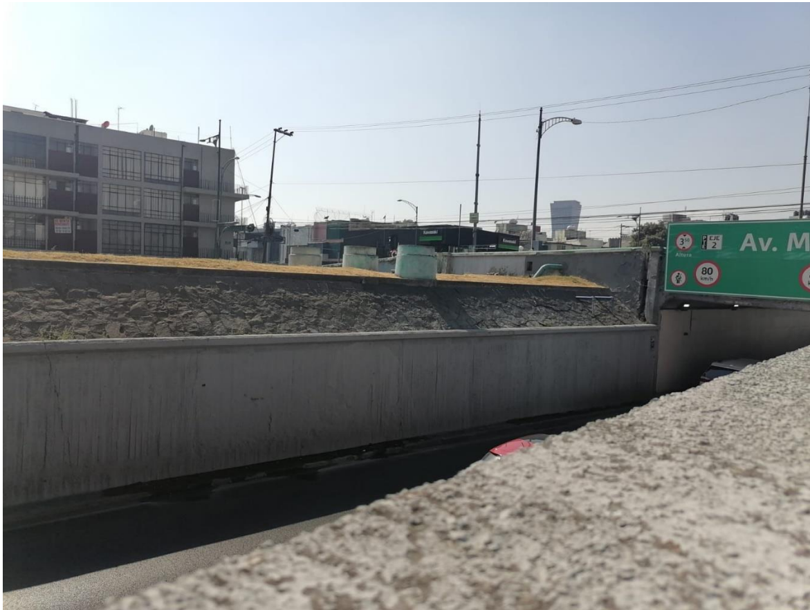
Figura 3.18 Viaducto Pdte. Miguel Alemán No. 87, visto desde la lateral dirección Tacubaya
