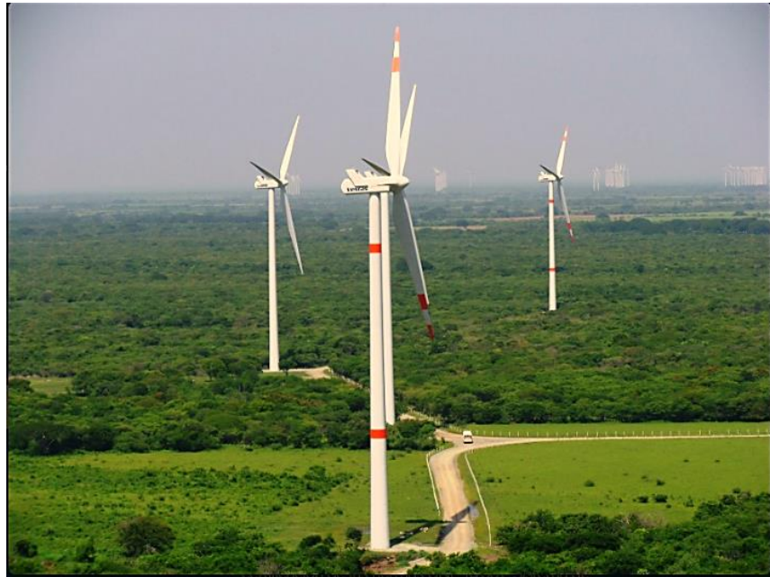
Figura 1.2 Central eólica Oaxaca I
