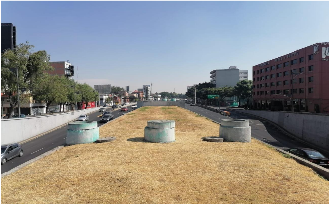
Figura 3.16 Viaducto Pdte. Miguel Alemán No. 87, visto desde el cruce Av. Monterrey
