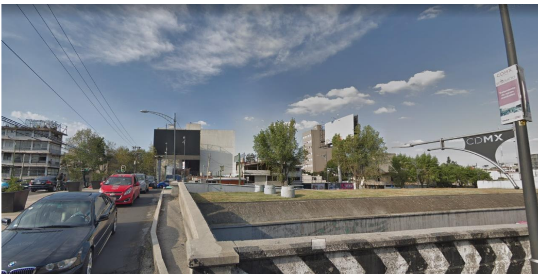
Figura 3.17 Viaducto Pdte. Miguel Alemán No. 87, visto desde la lateral dirección Aeropuerto
