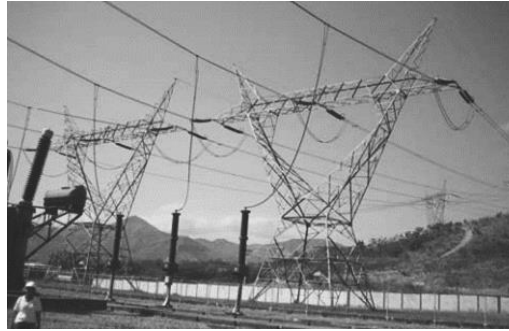
Figura 2.2 Torre con distribución de fases horizontal [6].
