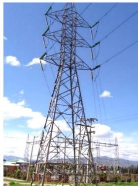
Figura 2.3 Vista real de torres de flexión [6].
