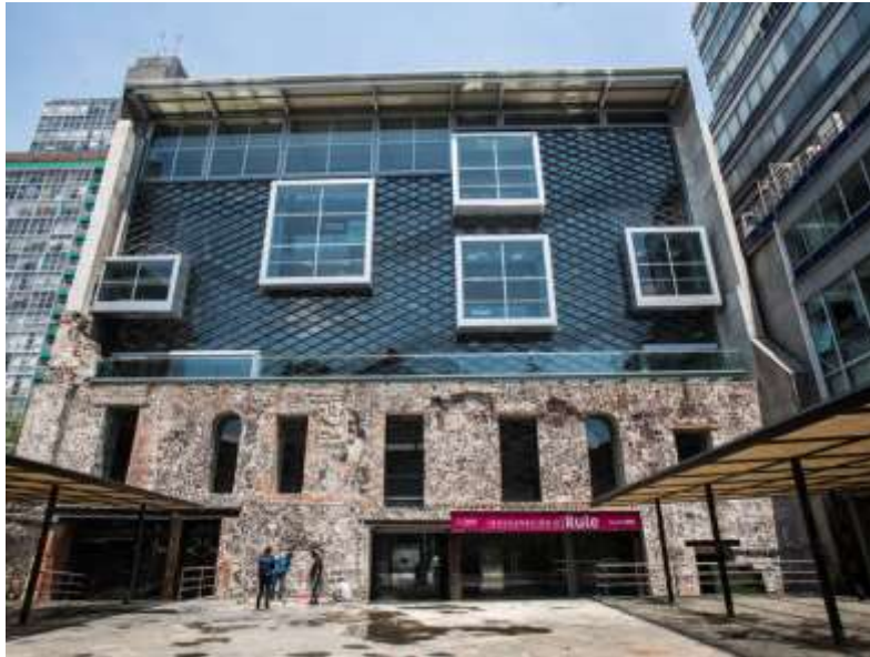
Fotografía 8. Fachada trasera del RULE.
