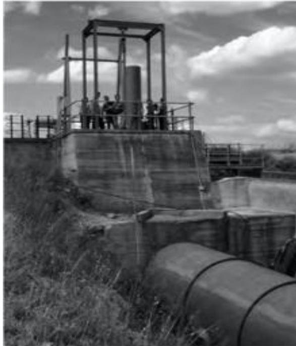
**Figura 1.13 Cámara de carga.**
