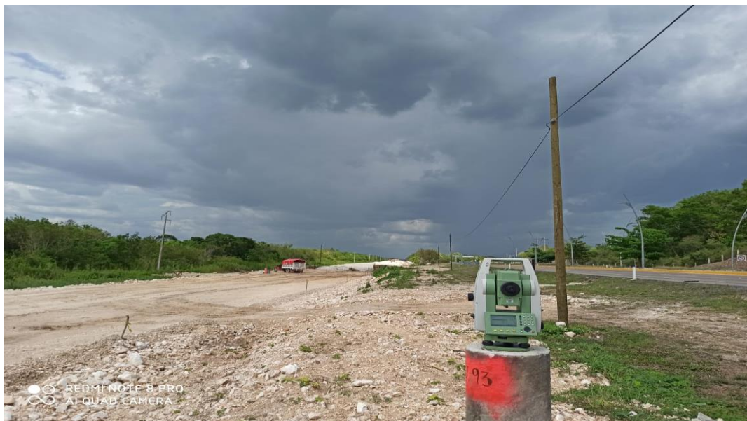
Imagen 11. Proceso de construcción de vías del Tren Maya, Tramo II, 2021. Elaboración propia.
