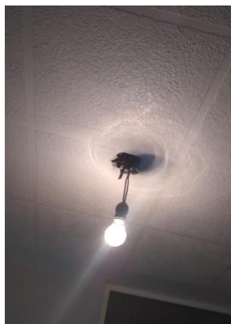
Figura 3.6 Luminaria incandescente instalada
