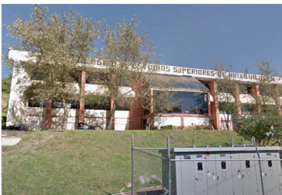
Imagen 28. Edificio de aulas
