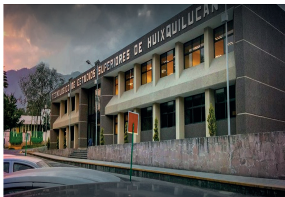
Imagen 29. Edificio de aulas
