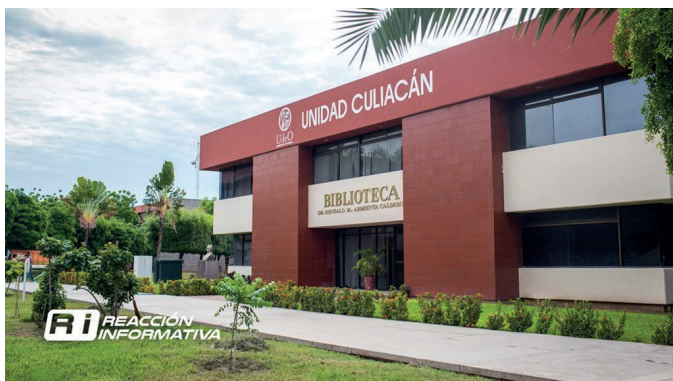
Imagen 33. Edificio de aulas
