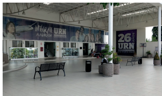
Imagen 31. Edificio de aulas
