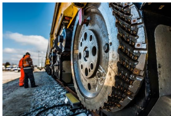
Fig. 19 Operación de fresado de rieles (milling) [86].
