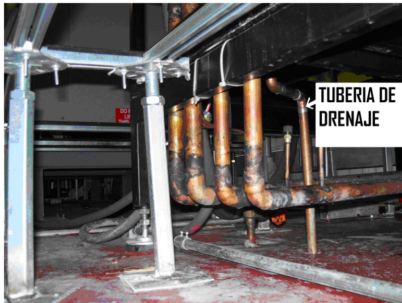
Fig. 22. Líneas de drenado de condensado
