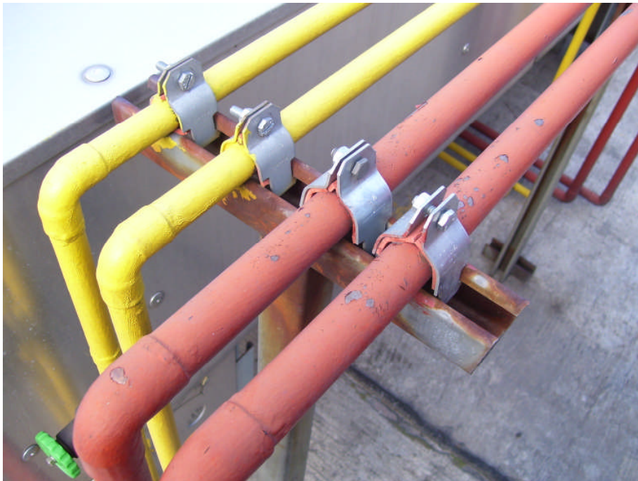
Fig. 21. Montaje y sujeción de las tuberías de succión y descarga
