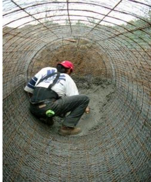
Figura 1.4 Se agrega cemento para hacer la forma cilíndrica en el enmallado.
