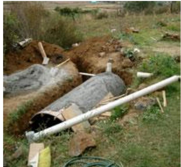
1.6 Colocación de los tubos de salida de lodos y fase líquida en la parte superior y entrada de materia prima.
