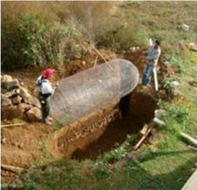
Figura 1.3 La estructura de enmallado se coloca en la fosa previamente preparada.
