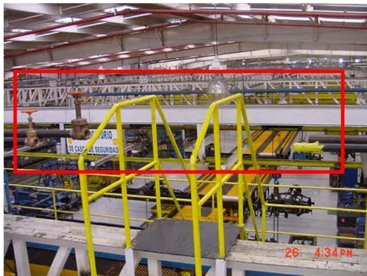
Fig. 28 Modificación de tubería existente en un arreglo tipo "U" para instalar escalera tipo "Paso de gato", para no inhabilitarla por completo.
