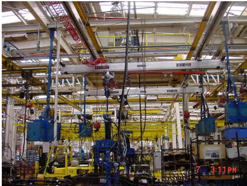
Fig. 12 Reacomodo del sistema de rieles para los compresores de resortes
