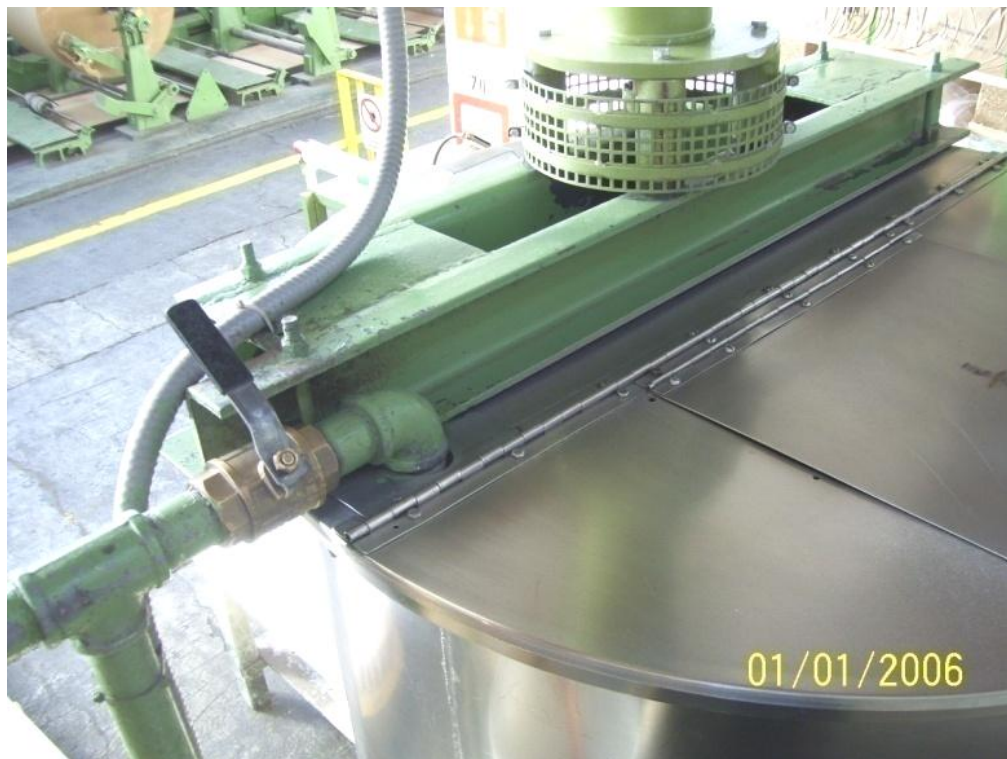
Figura 33 – Depósito de Pegamento
