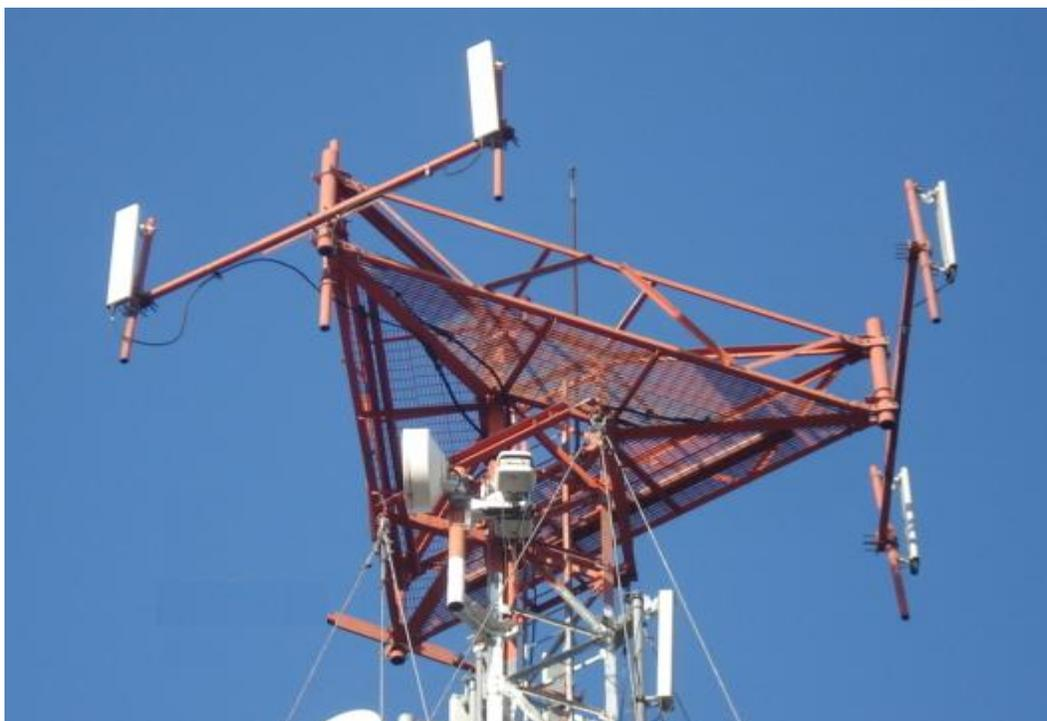
**FIGURA 4.8– ANTENAS PARA GSM**
