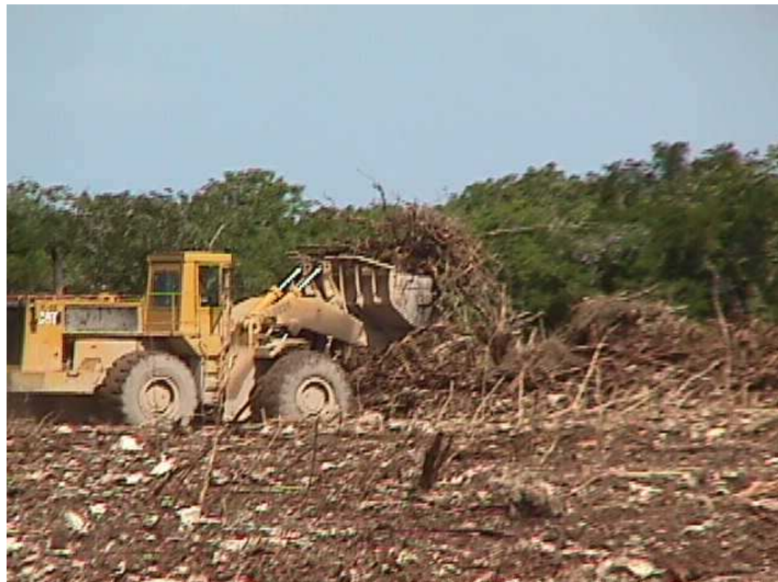
Despalme y Desmonte
