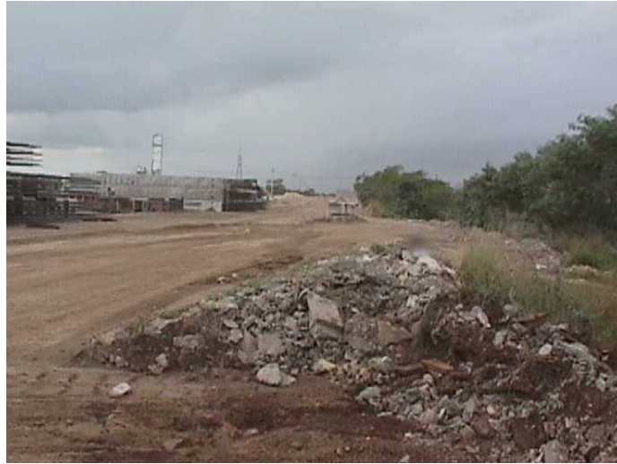
Camino de Acceso al Banco de Materiales
