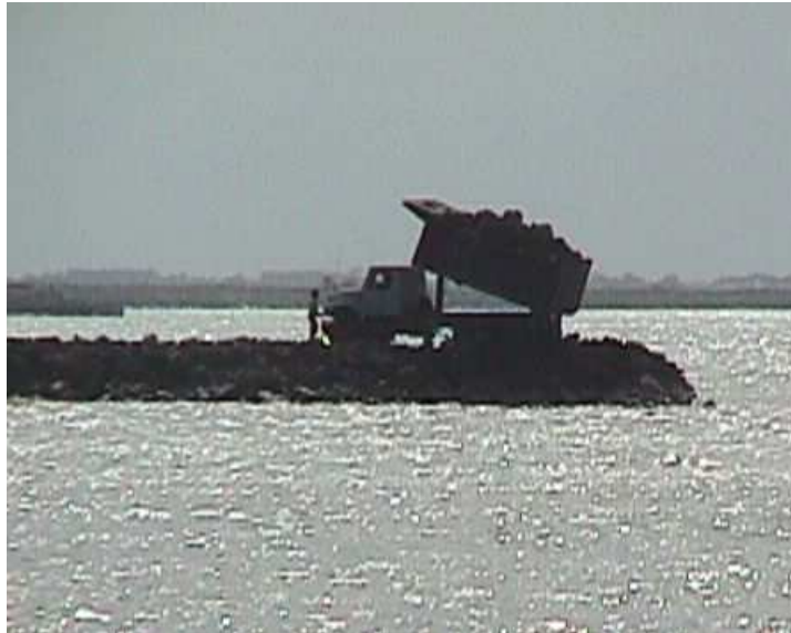
Colocación de Material para formación de Bordo de Contenedores
