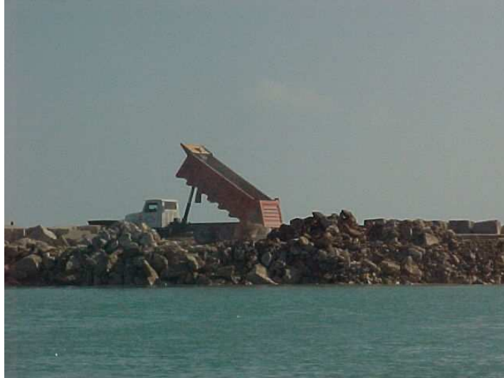
Colocación del Material en Rompeolas
