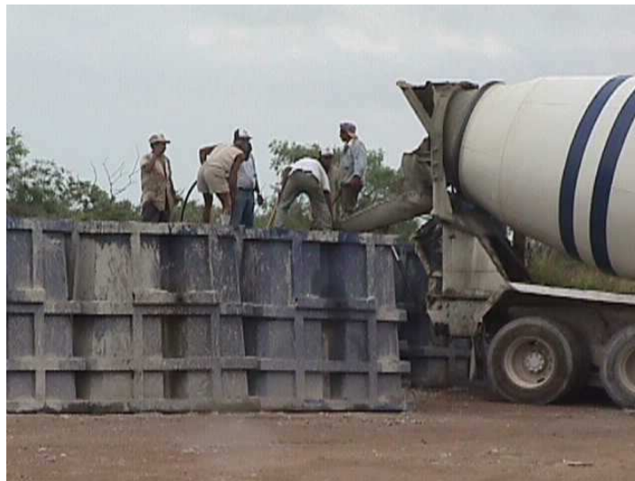
Colado de Cubos
