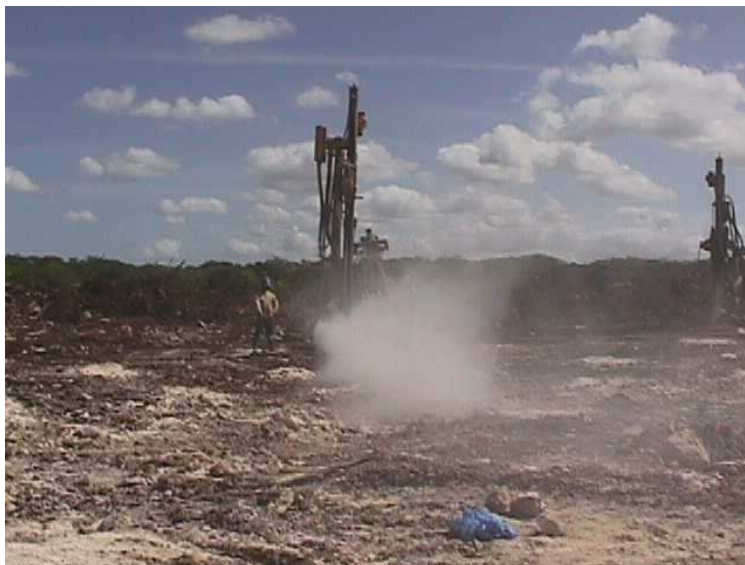
Se observa el Track Drill realizando Barrenación
