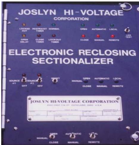
FIG. 9 a CONTROL DE UN SECCIONADOR.
