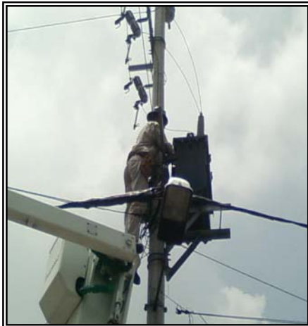
FIG. 32 a y b CAMBIO DE TAPS EN TRANSFORMADORES DE DISTRIBUCIÓN.
