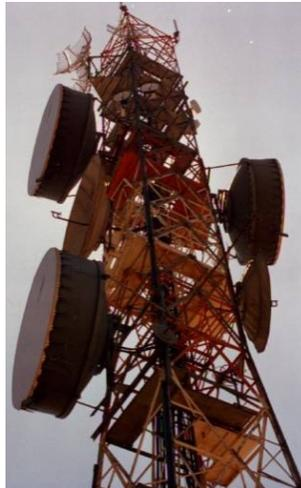
**Figura 4.2** Torre con antenas de microondas.
