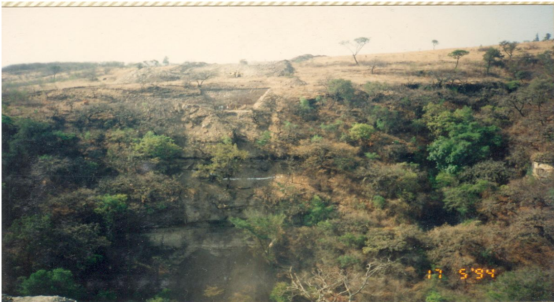
Foto No. 3.- Panorama de la zona, Barranca Calderón antes del inicio de la obra.
