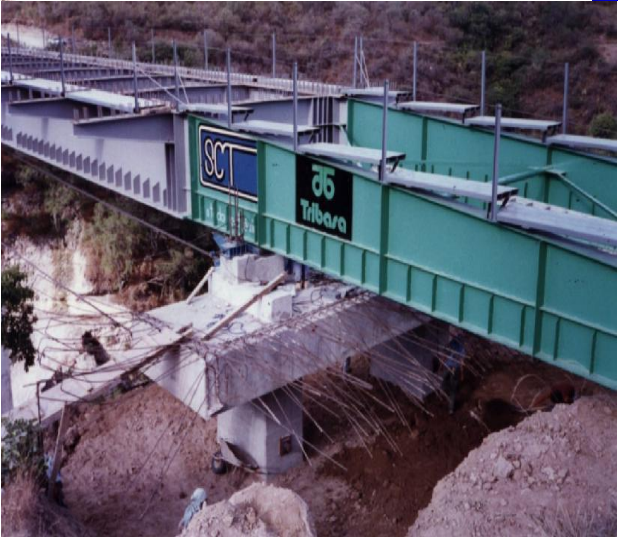
FOTOGRAFIA No. 16 Nariz de la estructura en estribo 5
