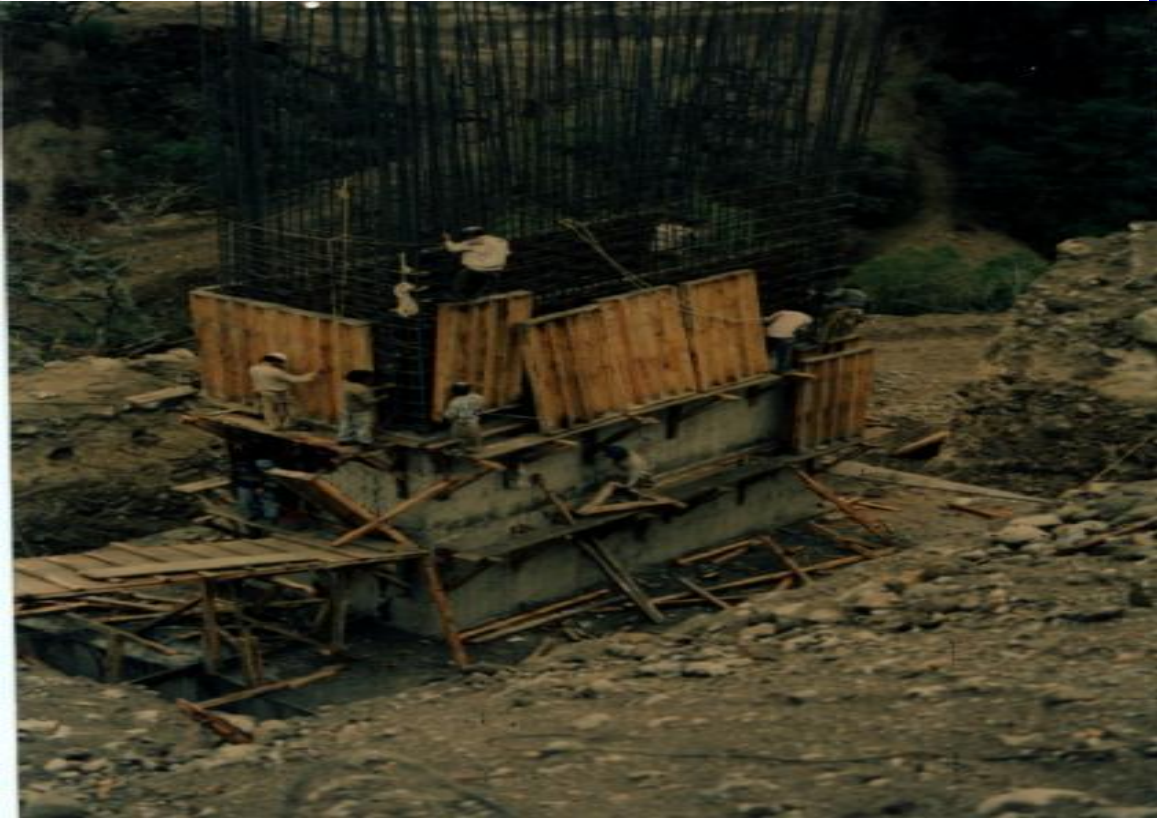
Fotografía No.11 Habilitado de cimbras para pilas.
