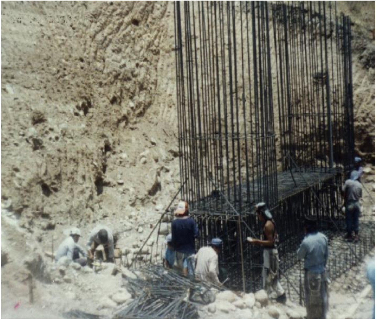
Fotografía No.10.- Desplante y armado de zapatas en pilas.
