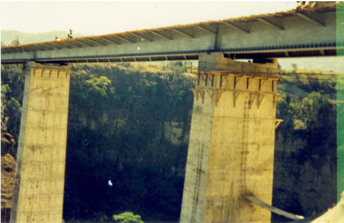
Fotografía No. 13 Cuerpo de pilas del viaducto “calderón”
