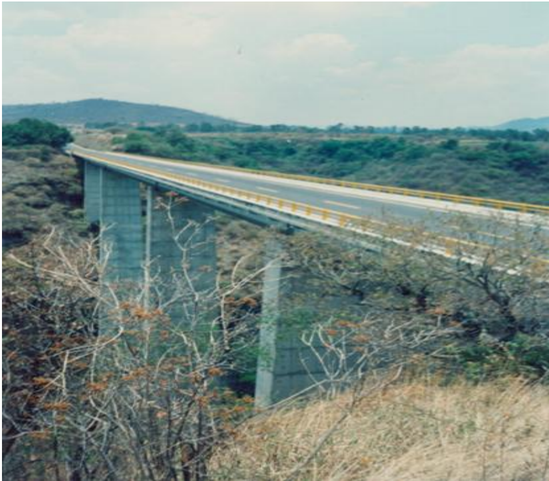
FOTOGRAFIA No.26 Se aprecian las pilas y el acceso del viaducto “Calderón” acabado.
