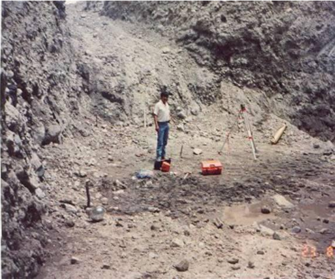
FOTOGRAFIA No. 8 verificando nivel de excavación en desplante pilas y estribos con equipo de topografía.
