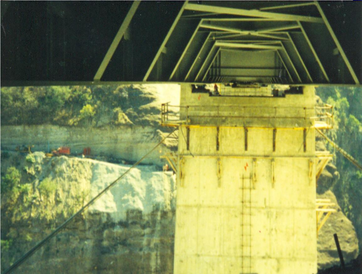
FOTOGRAFIA No.17 Aquí se muestra el diafragma en la parte inferior de la estructura de acero, la cual muestra el refuerzo de la estructura en todo lo largo del puente
