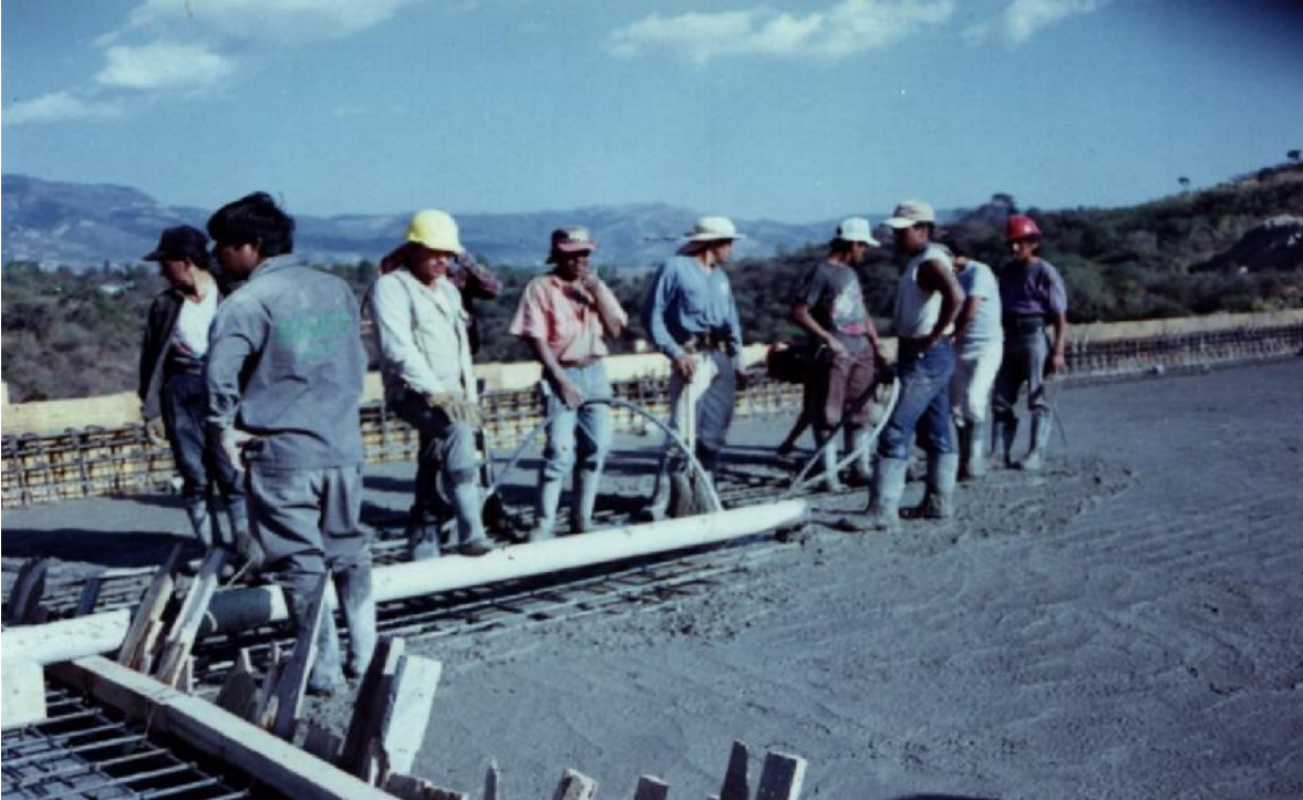
FOTOGRAFIA No.24 colado de losa de acceso concreto resistencia f^c=350\text{kg/cm}^2 en el puente Calderón. Se coló en tramos de 18 y 24 metros alternando hasta terminar.
