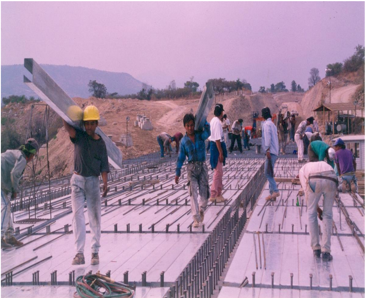
FOTOGRAFIA No.19 Se observa como se habilita y se coloca el monten de 20 por 7 cm. calibre 16 galvanizado sobre estructura del puente. Los conectores vienen integrados en dovelas
