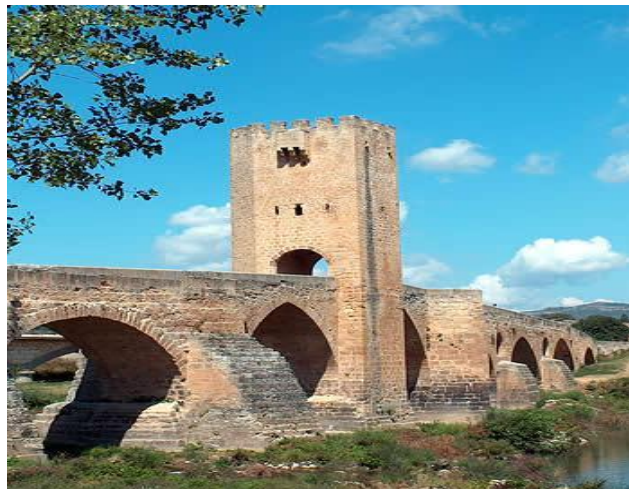
Foto No. 2.- Puente antiguo con torre en el eje
