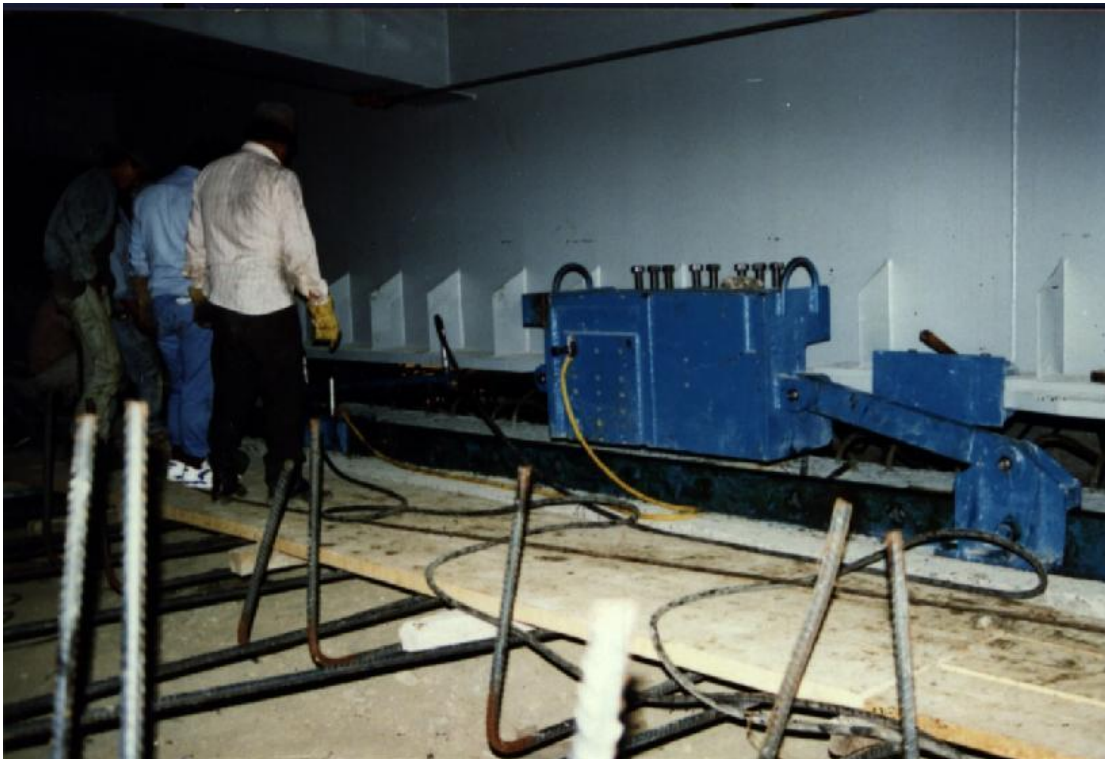
FOTOGRAFIA No.36 Bomba pupitre utilizada en el empujado de las estructuras del viaducto “Calderón”, haciendo uso de energía eléctrica de 440 volts; también
