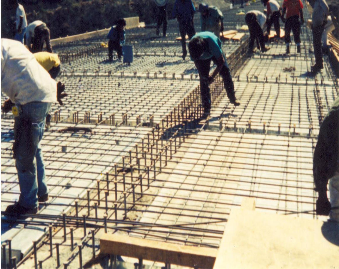
FOTOGRAFIA No.21 Empezando a colocar el acero de losa de acceso. El ancho de calzada es de 9.20 metros.
