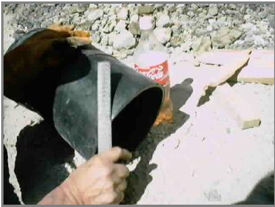
FOTO 36.-Se prepara el borde exterior del codo de la descarga por conectar a la red municipal, limando el labio exterior de la pieza.
