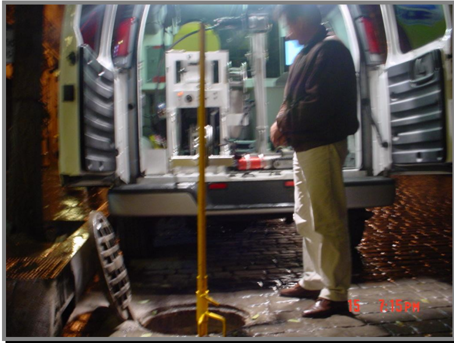
FOTO 4.-Estudio de la condiciones en que se encuentra la red de drenaje del Centro Histórico de la Ciudad de México, con ayuda del Sistema de Monitoreo de Circuito Cerrado de Televisión.
