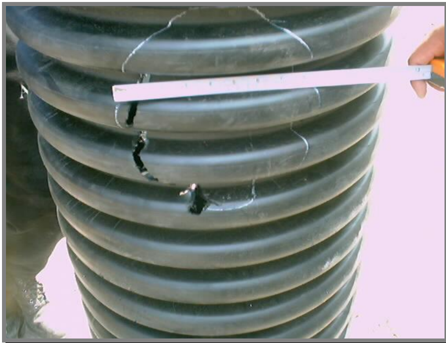
FOTO 28.-Preparación de una pieza especial en sitio. Trazo.
