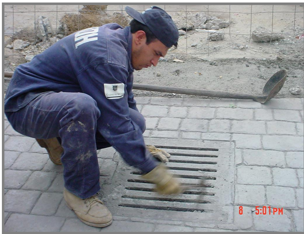
FOTO 60.-Limpieza de los pozos de visita y registros de las coladeras pluviales, interior y exterior.
