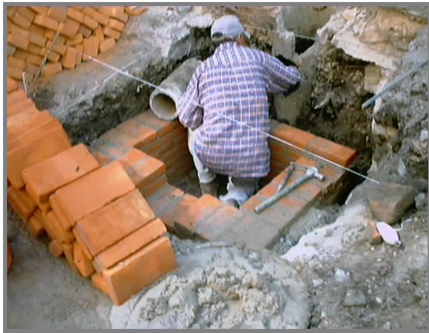
FOTO 44.-Otro momento del desarrollo de la construcción de los registros para las coladeras de banqueta y rejillas de piso.
