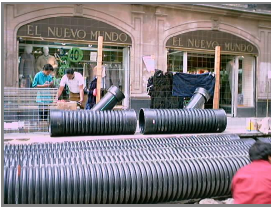
FOTO 25.-Preparación de las piezas especiales que recibirán las descargas domiciliarias.
