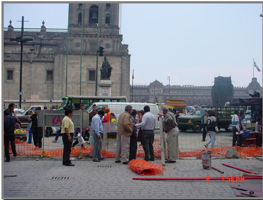
FOTO 6.-Delimitación de la zona de trabajo para la Rehabilitación de la red de drenaje del Centro Histórico de la Ciudad de México.
