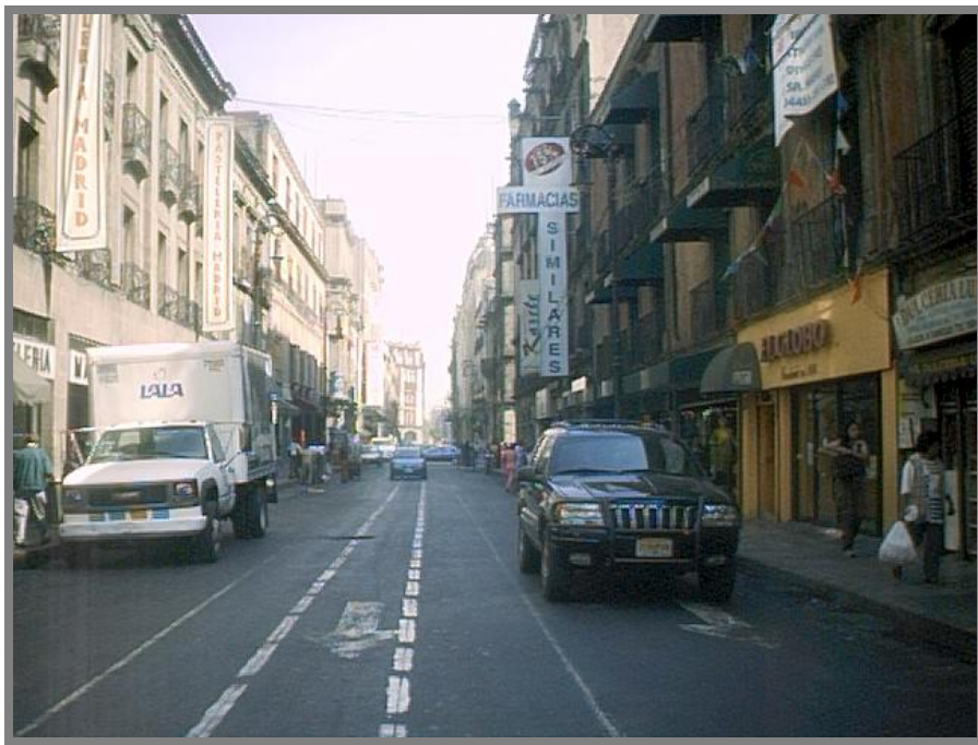
FOTO 7.-Trazo y nivelación de la trayectoria para la nueva canalización de la red de drenaje en el Centro Histórico de la Ciudad de México.
