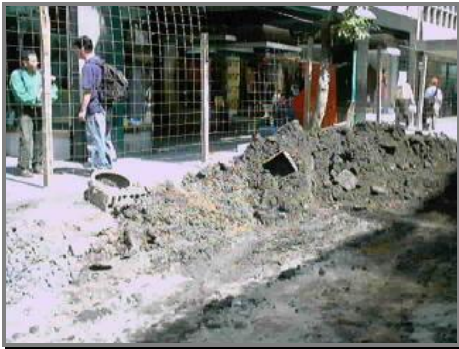
FOTO 54.-El relleno fluido se realiza hasta el nivel de sub – rasante, donde se desplanta la capa de concreto armado con mayor resistencia que la del relleno fluido.
