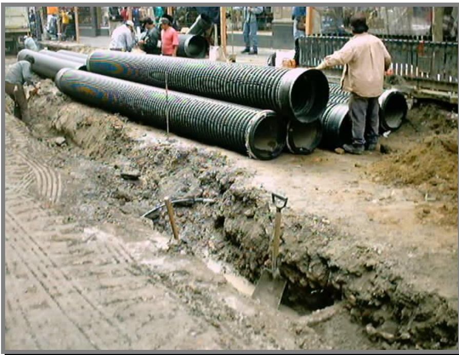
FOTO 23.-Revisión de la integridad del cuerpo y las campanas de los tubos, que no estén aplastados, ni rasgados, ni agrietados.
