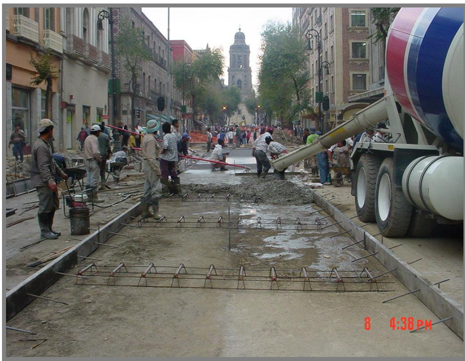
FOTO 53.-Colado de concreto de la carpeta de rodamiento (rasante)
