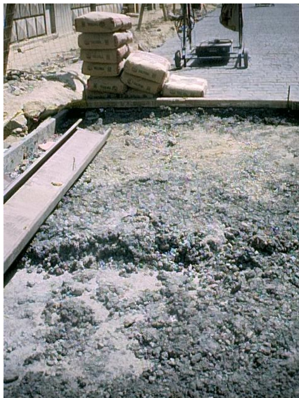
FOTO 54.-El relleno fluido se realiza hasta el nivel de sub – rasante, donde se desplanta la capa de concreto armado con mayor resistencia que la del relleno fluido.
