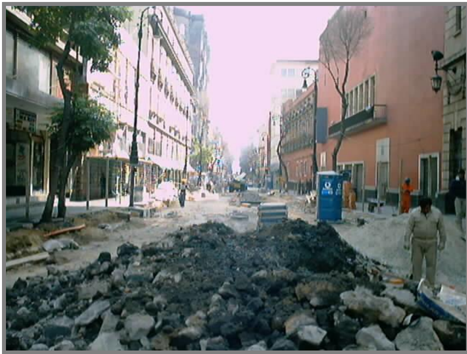
FOTO 8.-Corte y demolición de la carpeta asfáltica en las calles seleccionadas para rehabilitación de la red de drenaje.
