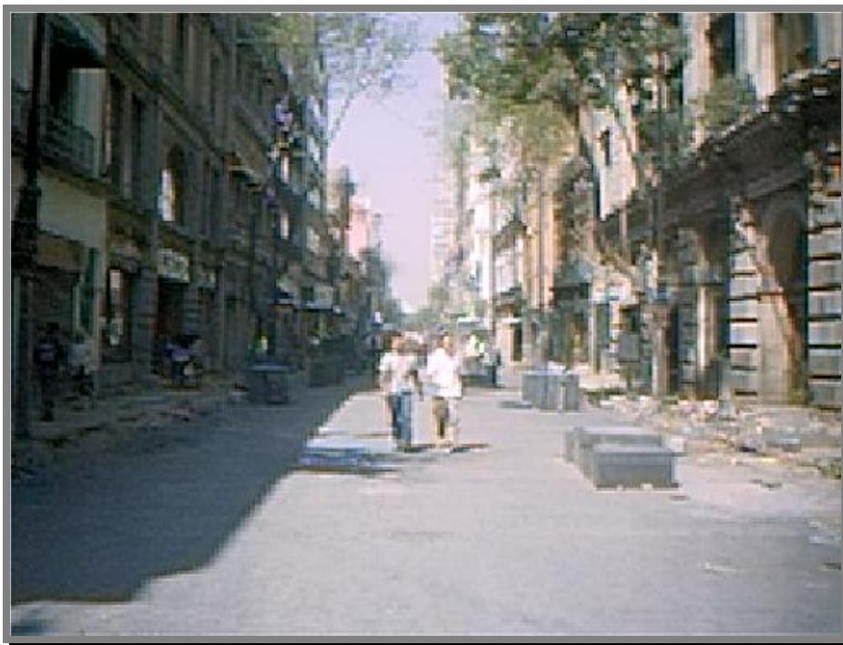
FOTO 52.-Calle terminada a nivel de sub rasante con relleno fluido, material con características similares al relleno con material de banco areno-limoso compactado al 95 % de la prueba próctor standard
