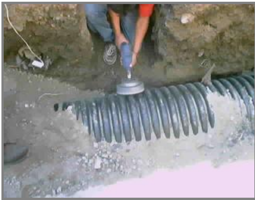
FOTO 34.-En seguida se perfora con una sierra con sacabocado
