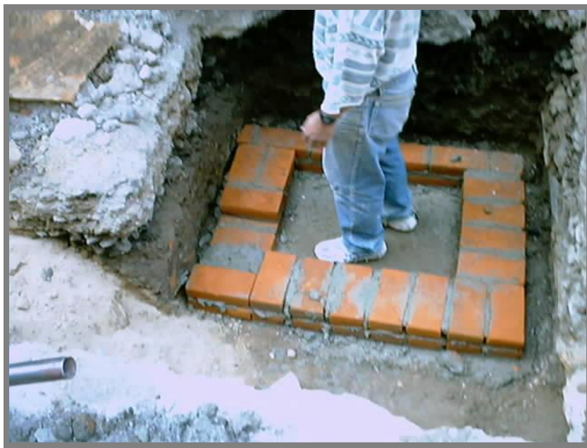
FOTO 43.-Construcción de los registros de las coladeras de banqueta y rejillas de piso.
