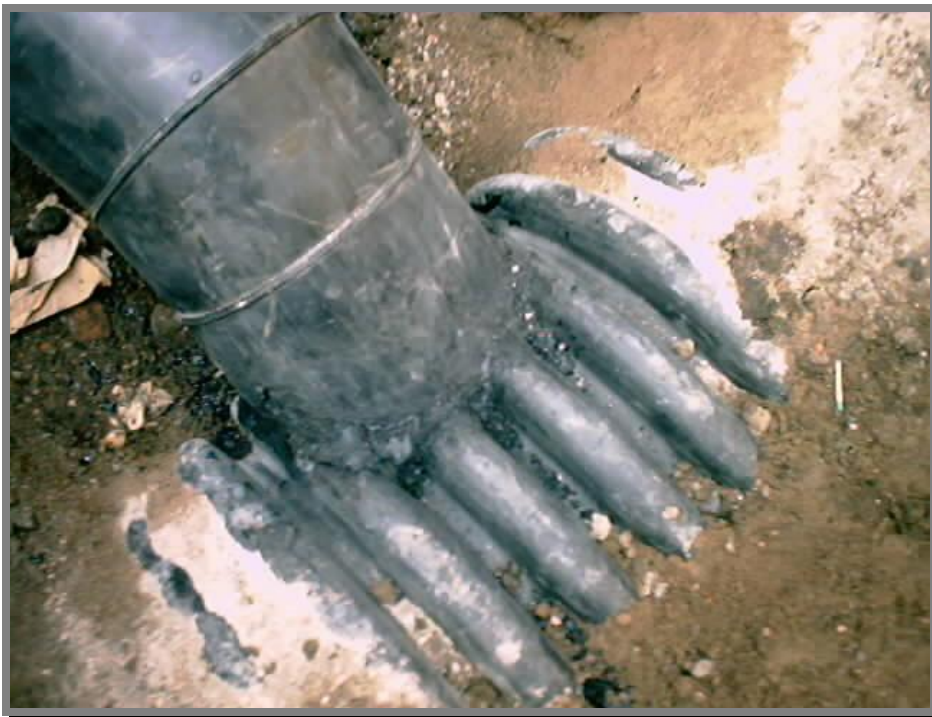
FOTO 39.-Pieza insertada y sellada en tubería instalada.
