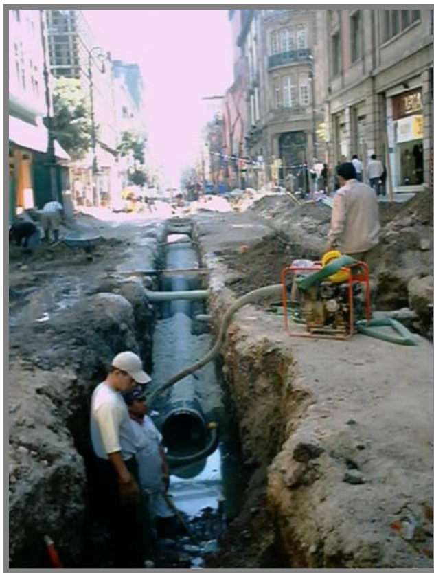
FOTO 49.-Una vez atracada la tubería para evitar flotación, se rellenó la zanja con concreto fluido.
