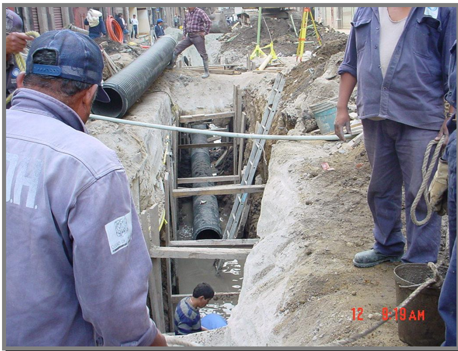
FOTO 20.-Otro aspecto de la instalación de la tubería de polietileno de alta densidad
