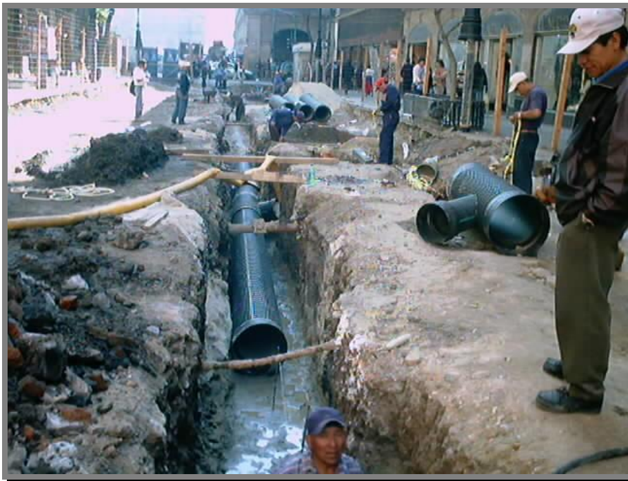
FOTO 19.-Instalación de la tubería de polietileno de alta densidad sobre una cama de relleno fluido para efecto de estabilidad de la misma.
