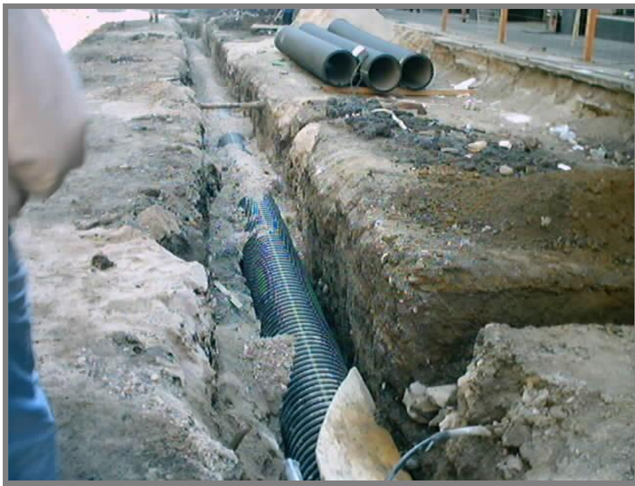
FOTO 50.-El material que debe de envolver a las tuberías de polietileno de alta densidad, preferentemente debe ser arena, para evitar que las aristas de algún material granular dañen la pared del tubo.
