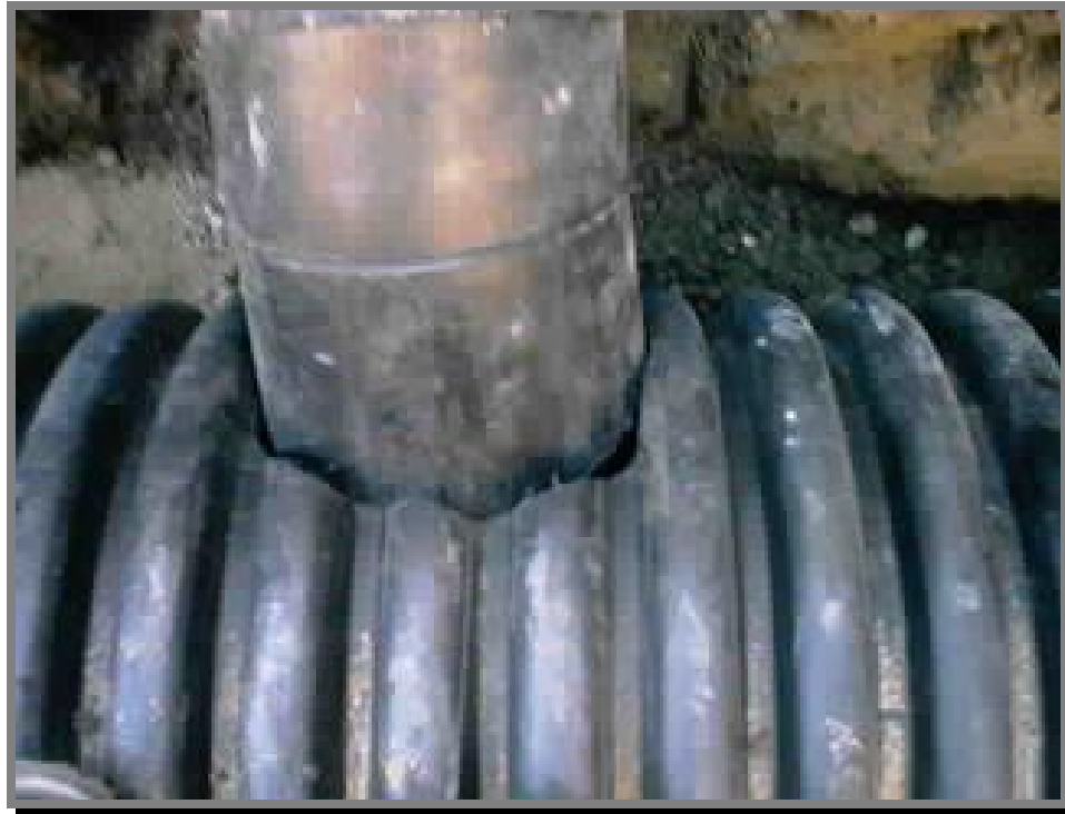
FOTO 37.-Se presenta el codo en el orificio perforado en el tubo principal, procurando que quede lo mas justo posible.
