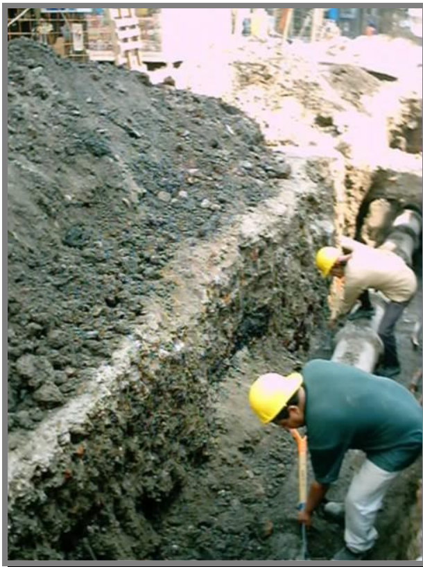
FOTO 16.- En este caso se trabaja sobre la tubería existente debido a que ésta será substituida en el mismo sitio por tubería de polietileno de alta densidad.
