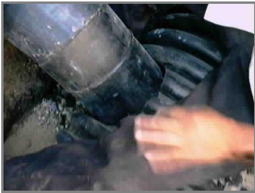
FOTO 30.-Inserción de la pieza por incorporar en el orificio perforado, en este caso en una tubería instalada.
