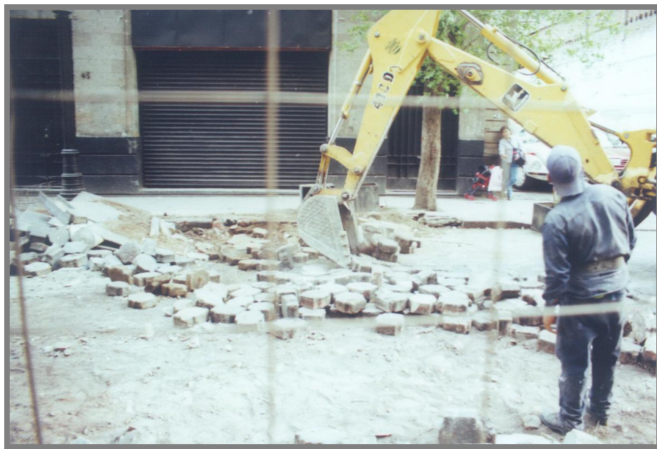
FOTO 9.-Remoción de la carpeta de adoquín y retiro de la sub-base.
