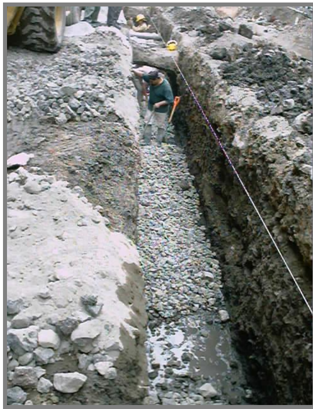
FOTO 18 .-En muchos sitios fue necesario aplicar un mejoramiento al suelo en el fondo de la cepa con grava a fondo perdido y encima la preparación de la cama de arena para el tendido de la tubería de polietileno de alta densidad.
