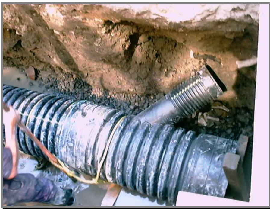
FOTO 27.-Pieza especial instalada que recibirá una descarga domiciliaria.
