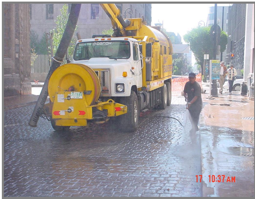
FOTO 59.-Limpieza de la carpeta terminada. Lavado con agua tratada a presión.
