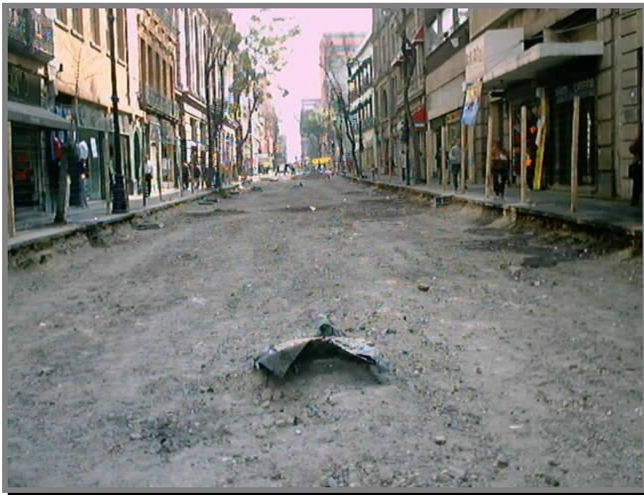
FOTO 11.- Carpeta asfáltica y/o adoquín retirado de la zona de corte.
