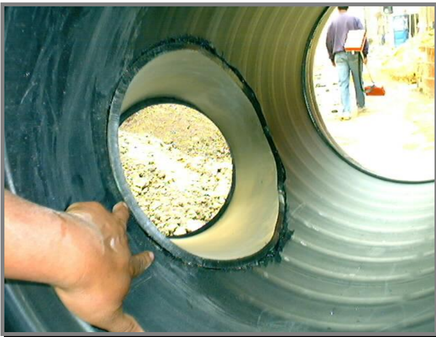
FOTO 31.-Preferentemente se debe trabajar la inserción del codo estando desmontada la pieza para tener acceso a recortar la proyección de la pieza insertada y sellarla por ambos lados.
