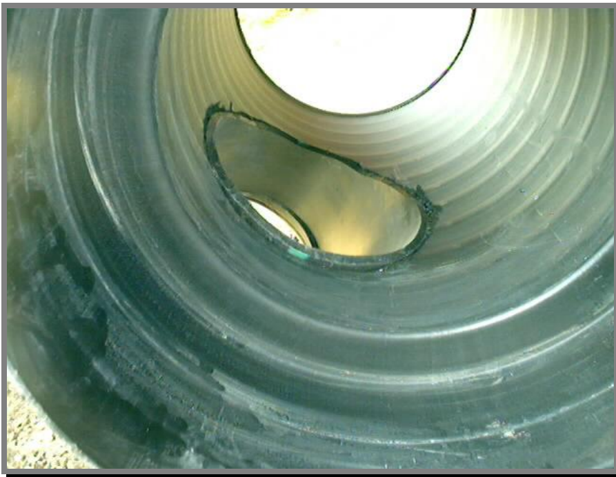
FOTO 32.-Pieza fabricada en sitio terminada
