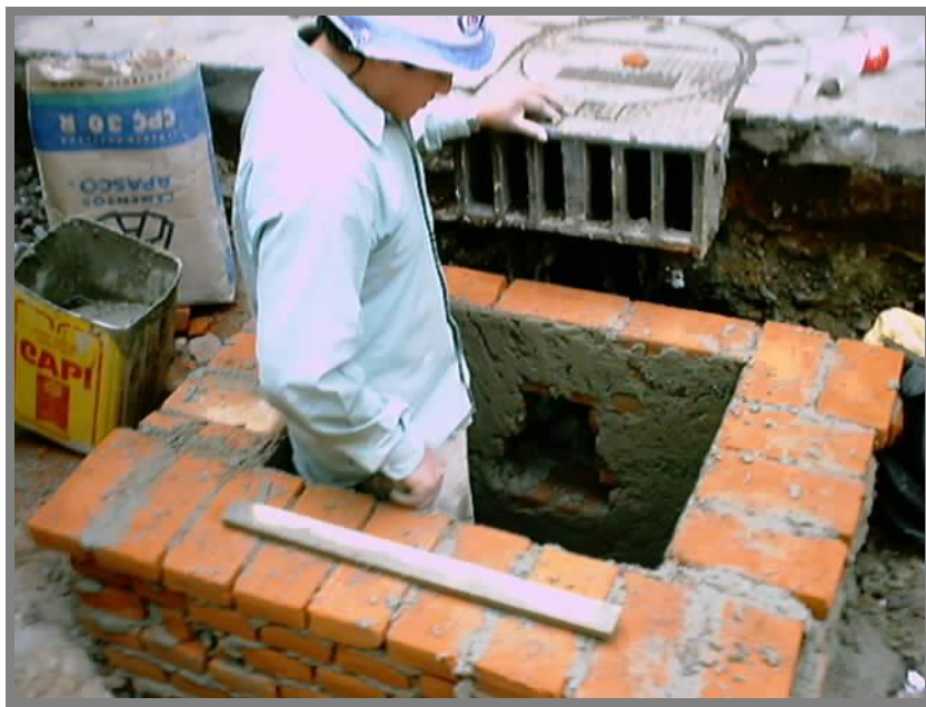
FOTO 45.-Ultima hilada de tabique reconociendo el nivel de descanso de la rejilla de piso.
