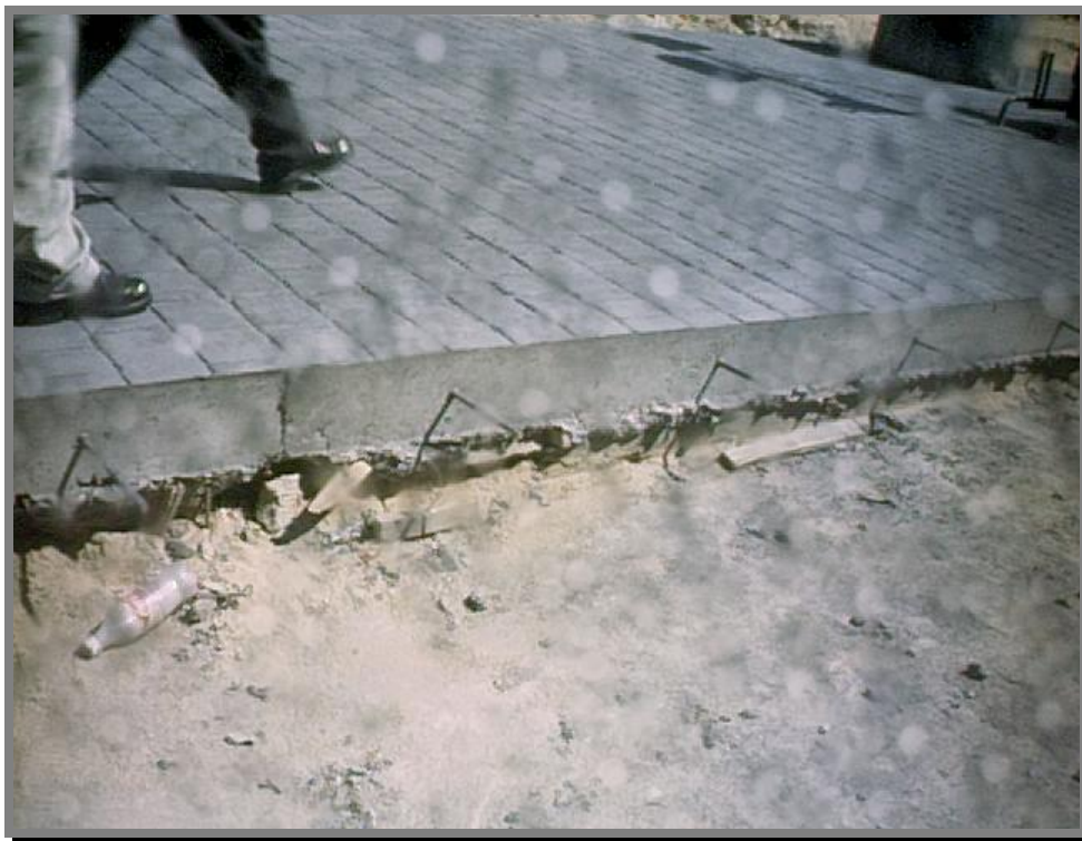
FOTO 56.-Carpeta de rodamiento de concreto armado con estampado de adoquín aparente.
