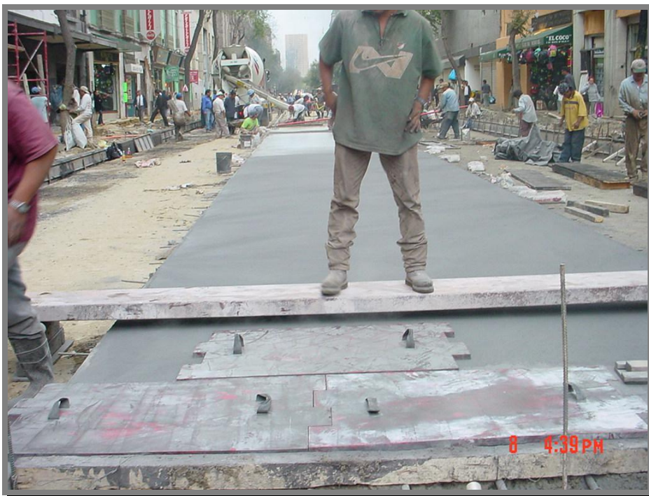
FOTO 57.-Estampado de adoquín aparente durante el proceso de fraguado.
