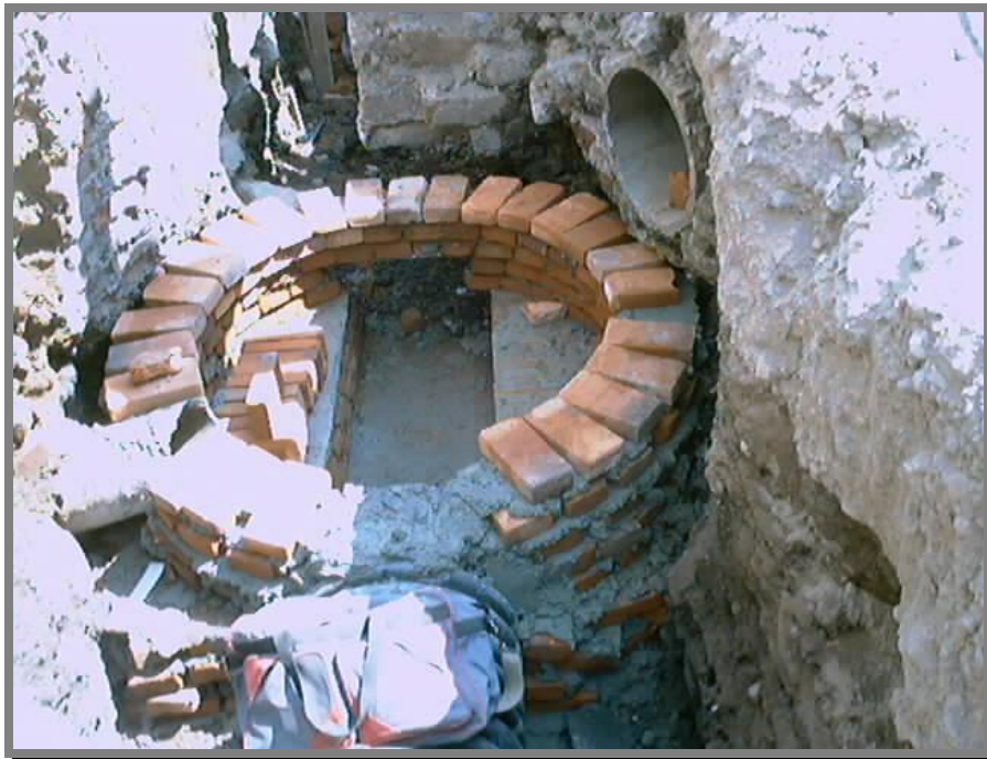
FOTO 42.-Otro ángulo de observación de la construcción del pozo.
