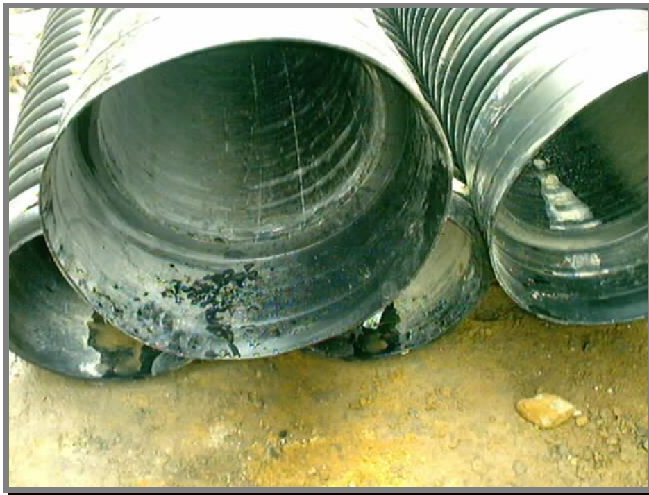
FOTO 22.-Preparación de las campanas, revisión y limpieza.
