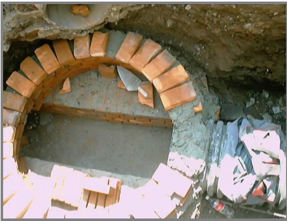
FOTO 41.-Construcción de los pozos de visita de tipo común de tabique rojo recocido y zampeado de mortero – arena.
