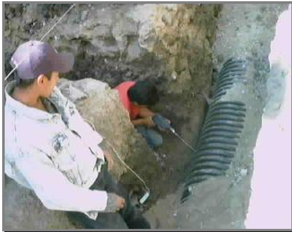
FOTO 33.-Preparación del orificio para instalar una conexión de una descarga domiciliaria no prevista, en tubería ya instalada. Primero se taladra una perforación guía con broca de \frac{1}{8} " de diámetro.
