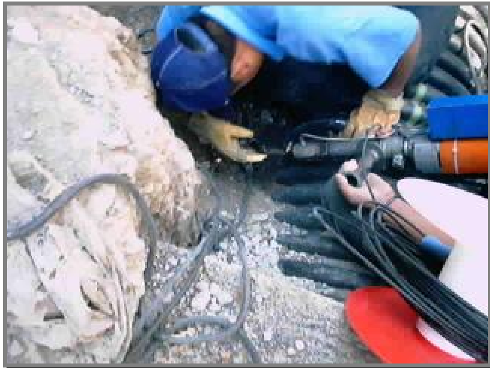
FOTO 38.-Aplicación de resina epóxica para sellado de polietileno.
