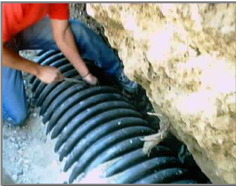
FOTO 35.-Una vez perforado el orificio, se liman y se retiran los residuos del borde.
