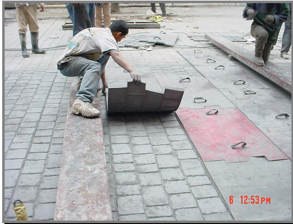
FOTO 58.-Estampado de adoquín aparente durante la etapa de fraguado de la capa de concreto de tipo estructural armado.
