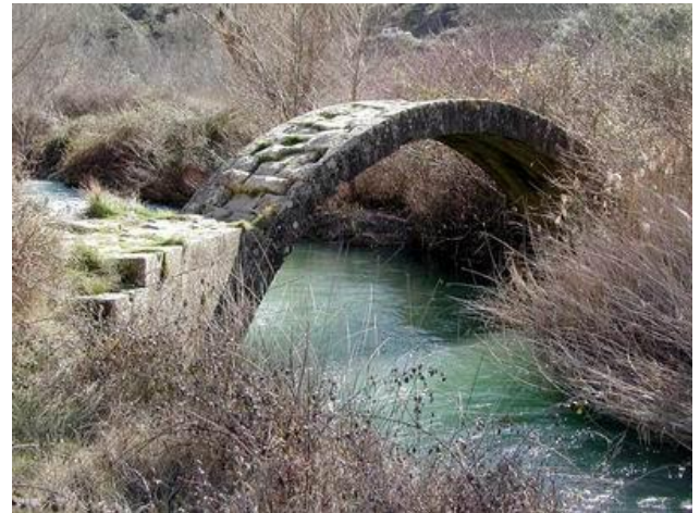
Fig. 1.3 Puente en arco a base de piedra Fuente: es.wikipedia.org
