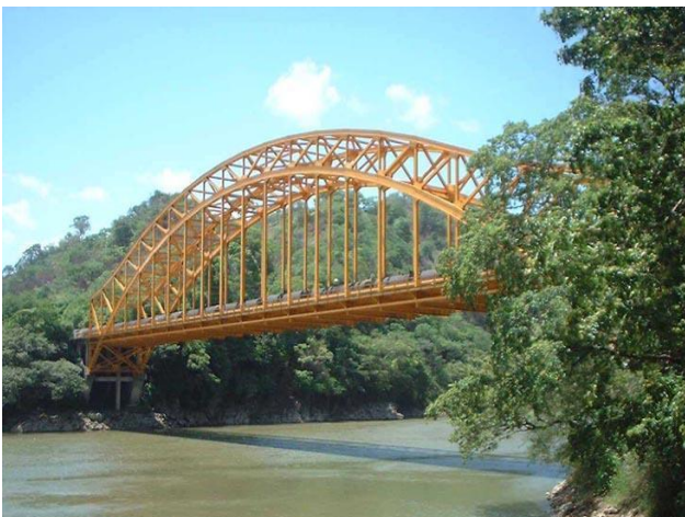
Fig. 1. 8 Puente de Acero Estructural Fuente: www.tenosique.com
