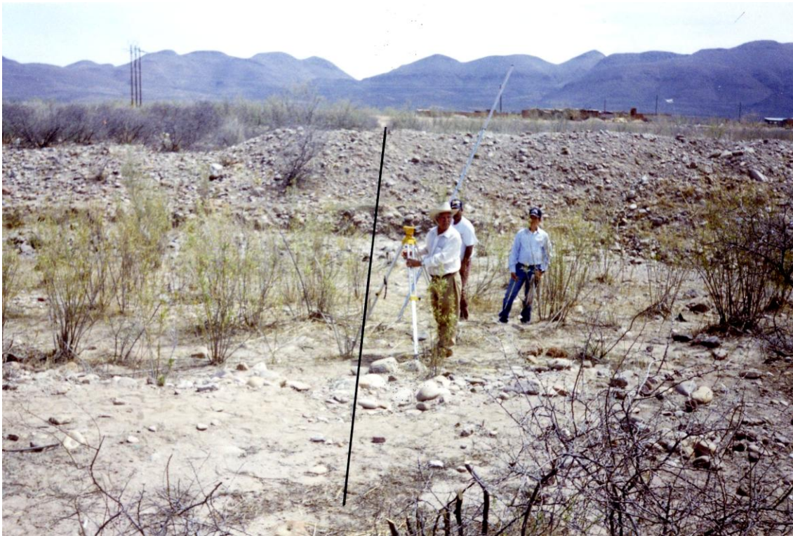
Fig. 2.5 Trabajos de topografía, donde se observa la utilización de equipo topográfico, estadalero y ayudante.
