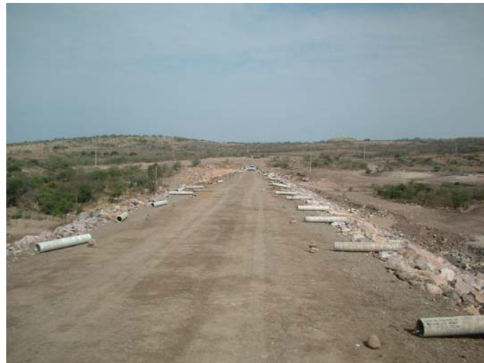
Fotografía No. 22: aquí se puede apreciar el revestimiento de la corona ya colocado
