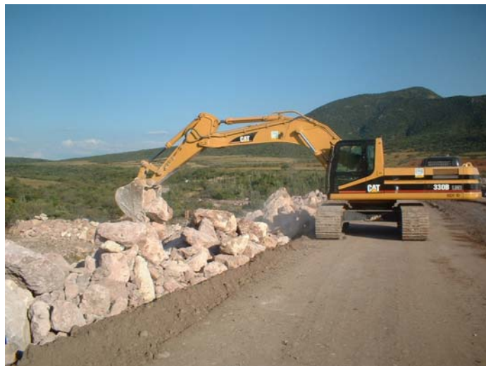
Fotografía 21: acomodo de enrocamiento de protección con retroexcavadora caterpillar 330B
