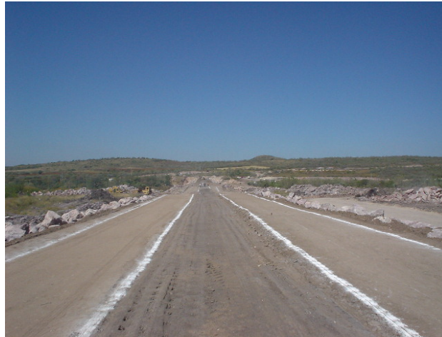
Fotografía 15: encalado para la colocación de materiales graduados en cortina
