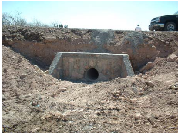
Fotografía 42: cabezal de mampostería
