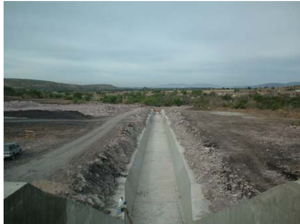
Fotografía 37: canal de descarga concluido
