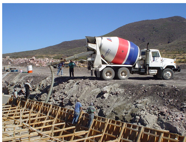
Fotografía No. 36.- trabajo de colado de muros de vertedor
