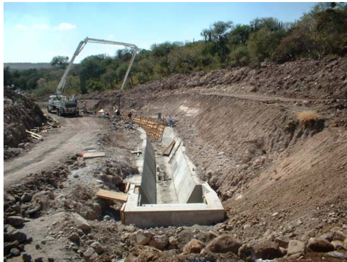
Fotografía 29: caja disipadora y canal de desagüe en proceso de construcción
