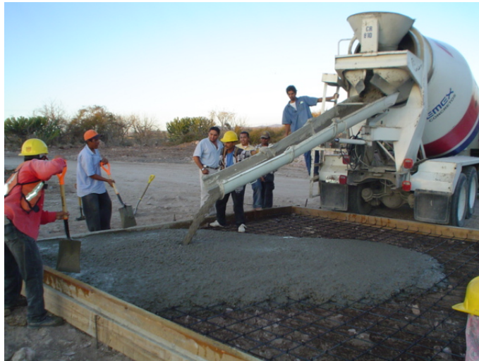
Fotografía No. 03.- plancha de concreto para los trabajos de mantenimiento de maquinaria
