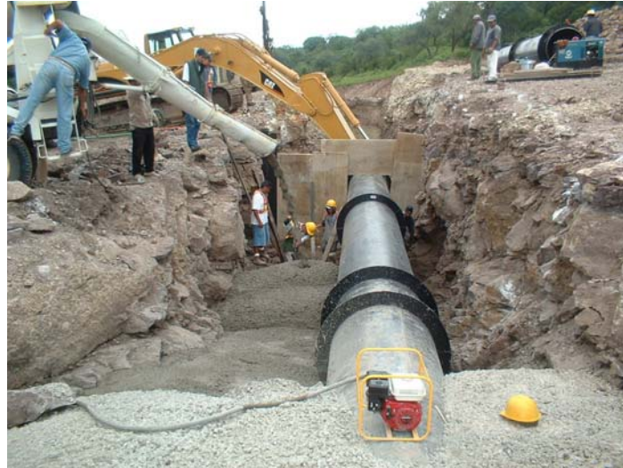
Fotografía 27: colocación y encofrado de tubería de desagüe de fondo
