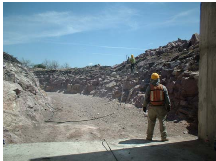
Fotografía 31: excavación de canal de llamada en la zona de transición
