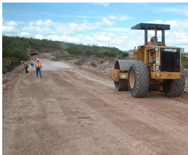
Fotografía No. 40.- colocación y compactación de material de tepalcate para dar nivel al desplante del camino de restitución.
