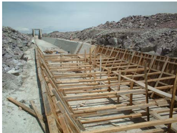
Fotografía 35: canal de descarga casi concluido
