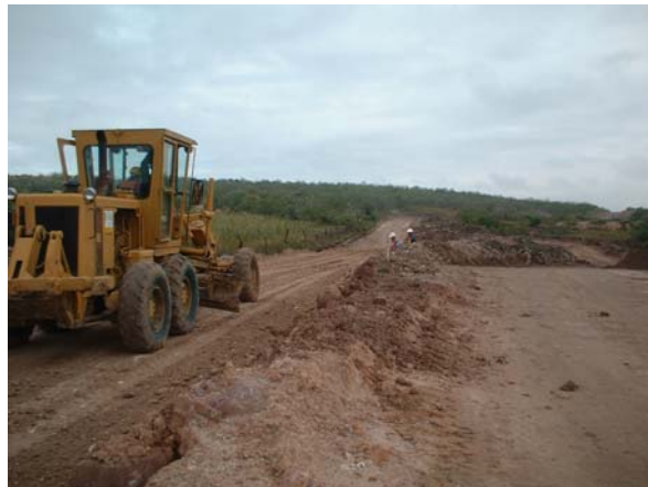
Fotografía No. 39.- colocación y conformado de material de tepalcate
