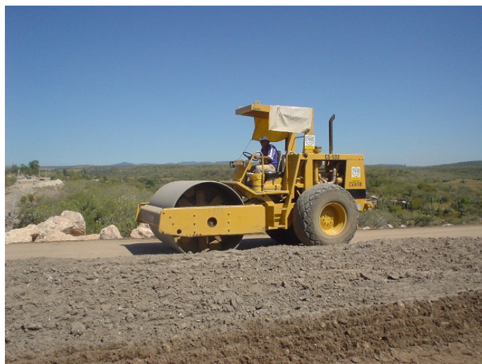
Fotografía 19: compactación mediante rodillo liso caterpillar CS533
