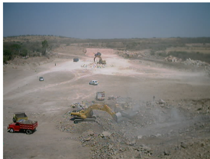
Fotografía 10: toma de los trabajos de desmonte y despalde
