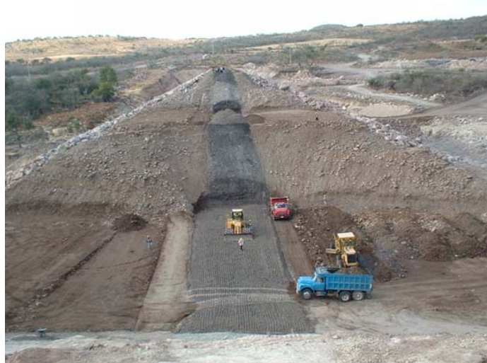
Fotografía 18: toma de la colocación de materiales graduados en cortina
