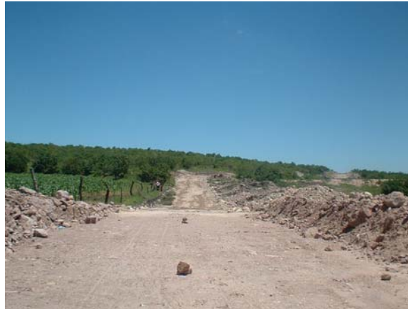
Fotografía 38: desmonte, despalme y excavación en camino
