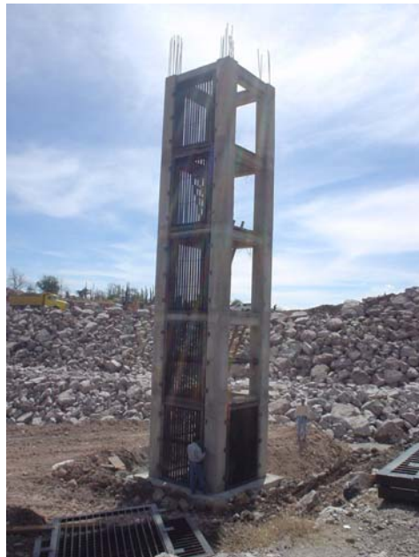
Fotografía 25: aquí se aprecia la obra de toma en construcción
