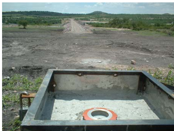
Fotografía 24: monumento de colimación ubicado en la margen izquierda de la cortina,
