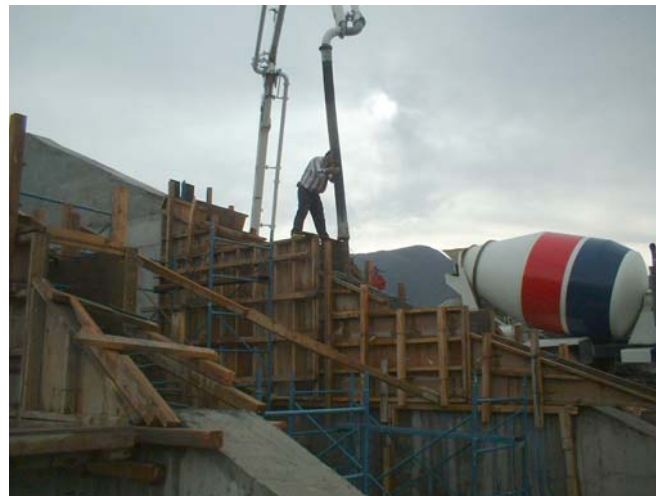
Fotografía No. 33.- colado de muros de puente de vertedor mediante bomba
