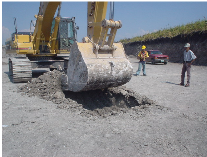
Fotografía 3: sondeo por pozo a cielo abierto de uno de los bancos de material
