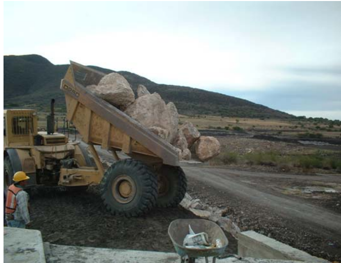
Fotografía 20: vaciado de enrocamiento de protección con camión yucle caterpillar D25D
