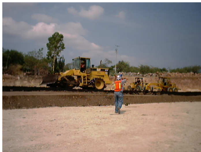
Fotografía 8: formación de terraplén de prueba
