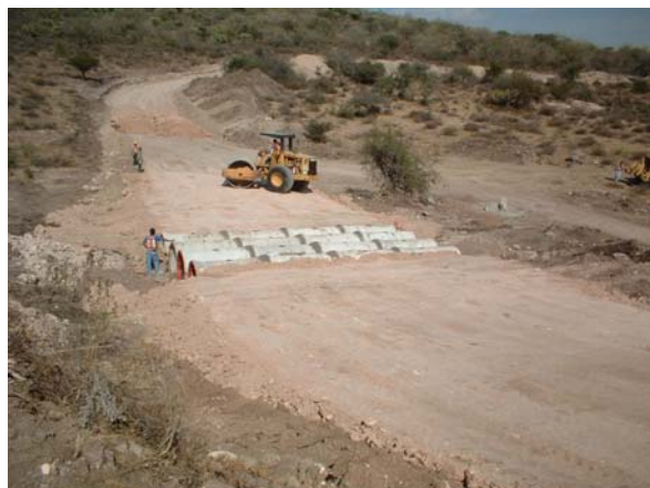
Fotografía 41: colocación de material de tepetate y tubería de concreto para construcción de alcantarilla
