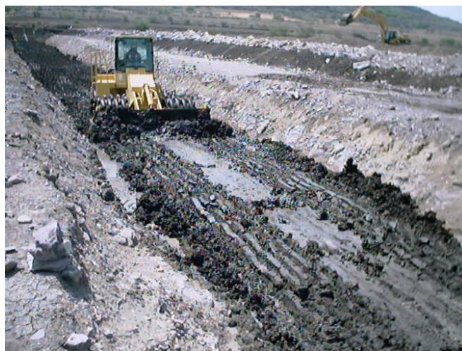
Fotografía 13: colocación y compactación de arcilla con rodillo pata de cabra caterpillar 815F
