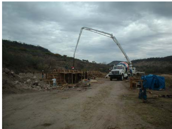
Fotografía 43: construcción de alcantarilla sección cajón
