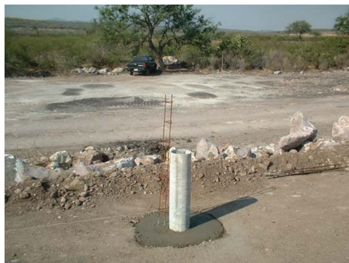
Fotografía 23: colocación de guardacamino
