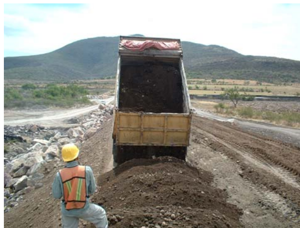
Fotografía No. 16: vaciado de materiales de grava-arena en cortina
