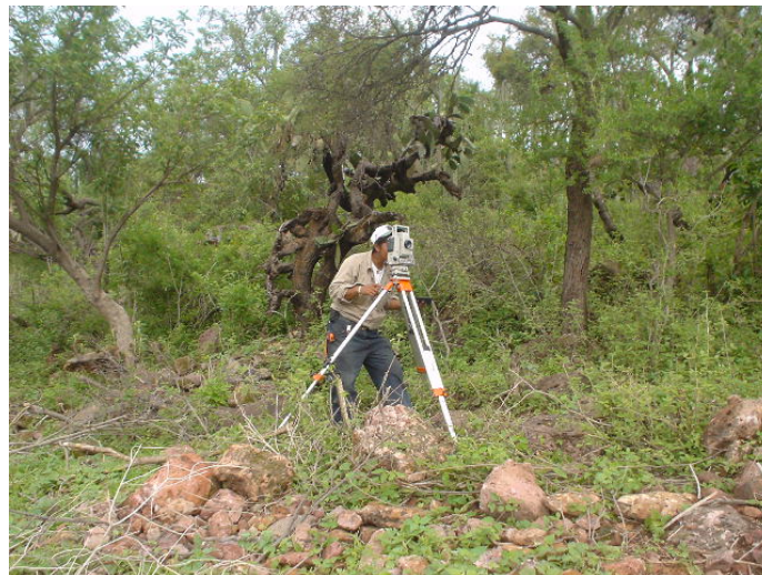
Fotografía 2: trabajos de topografía en bancos de materiales
