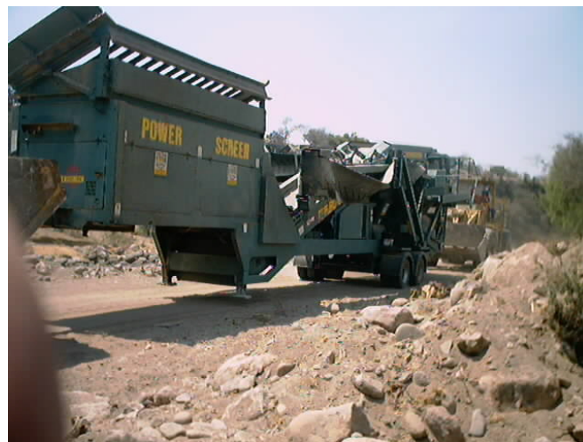
Fotografía 5: Llegada a obra de maquina cribadora portátil power screen
