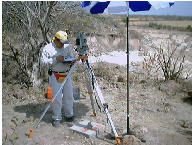
Fotografía 1: trabajos preliminares de topografía
