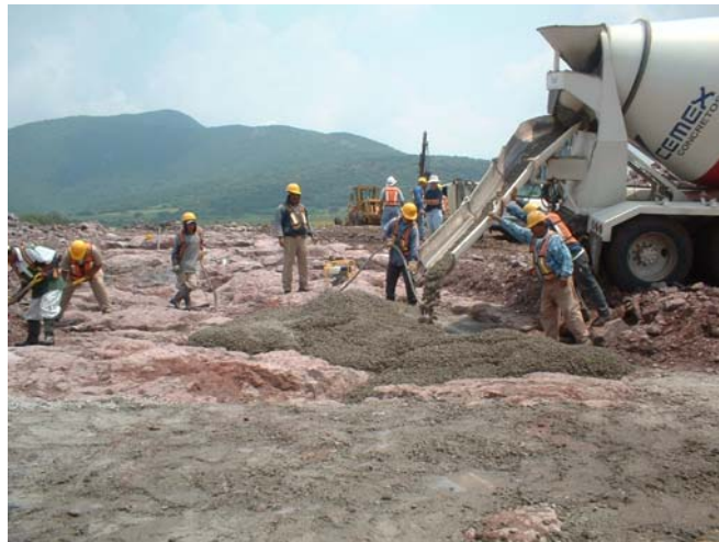
Fotografía 12: colocación de concreto para la colocación de arcilla
