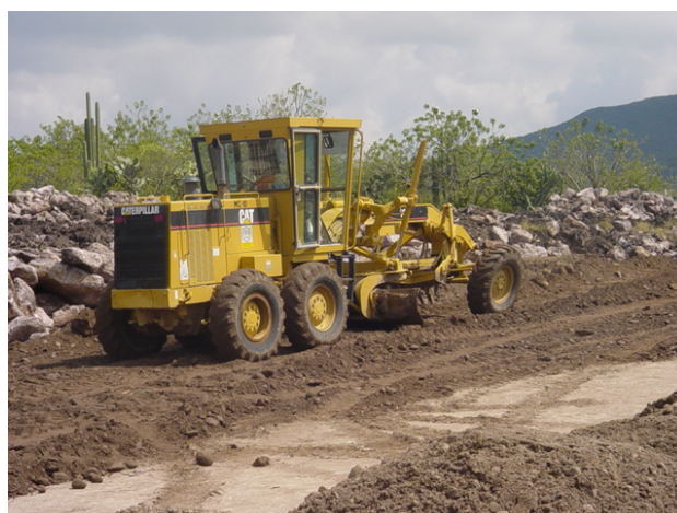
Fotografía No. 17: homogenizado y conformación de material de grava-arena
