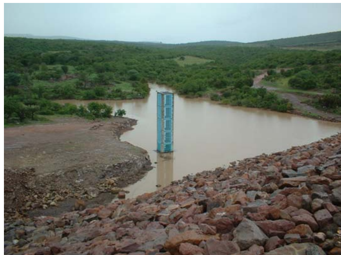
Fotografía 26: obra de toma terminada y en funcionamiento
