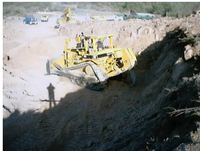
Fotografía 9: trabajos de desmonte y despalde en área de la cortina mediante tractor caterpillar D8
