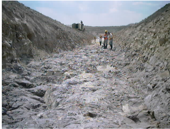
Fotografía 11: trabajos de limpieza mediante compresor para la colocación de arcilla
