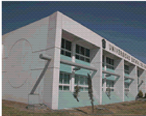
Foto No. 4. Edificio de aulas (Acupuntura médica, Ingeniería en comunicación multimedia, Licenciatura en quiropráctica) muestra tanto el diseño y acabados, los cuales son muy similares a los del T.E.S.E.
