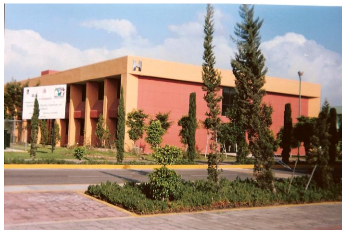
Foto. No.3. Estructura y diseño acústico hacia el exterior del edificio de contaduría.
