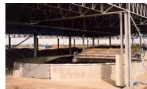
Fig. II.-20: Volteador de túnel mediante palas.
