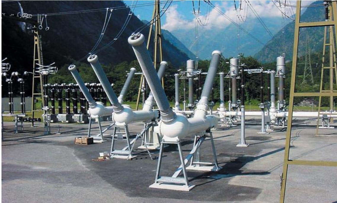
Figura C. SUBESTACIÓN HÍBRIDA
