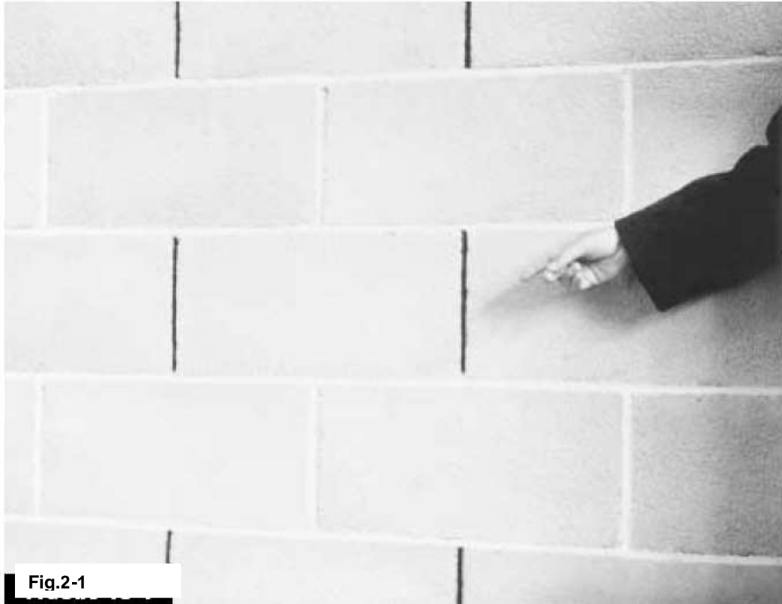
Fig.2-1 Tipo de resonador Helmholtz construido dentro del muto de la Topiola Church en Helsinki, Finland. Las ranuras y cavidades detrás de ellos actúan como ambos absorbedores y difusores de sonido.
