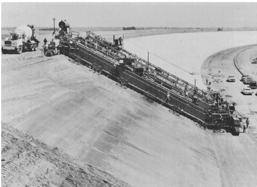
Figura 2. Construcción del acueducto de California diseñado para manejar 5.22 billones de m 3 de agua. 1
