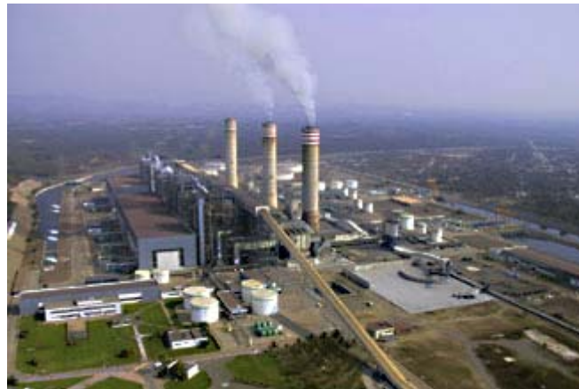
Figura 13. Carbo-eléctrica Nava Coahuila (Fuente CFE)
