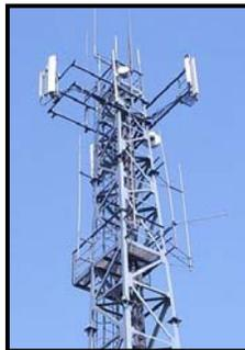
*Figura 2.1 Estación base GSM*
