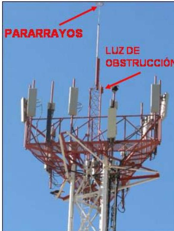
*Figura 3.2 Torre con pararrayos y luz de obstrucción.*
