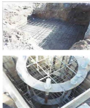
*Figura 3.28 Torre Monopolo y Cimentación para Torre Monopolo*
