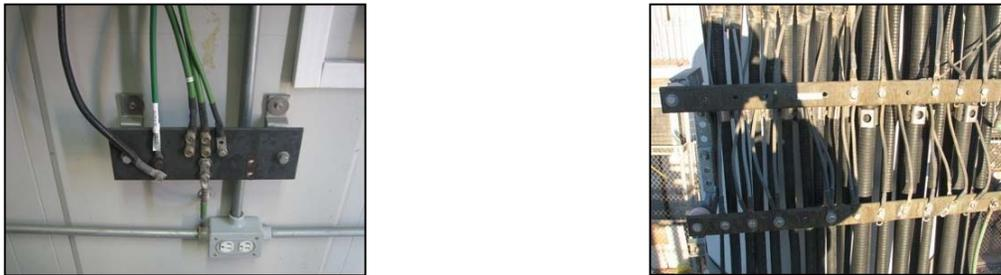
Figura 3.14 barras de cobre para tierra física.
