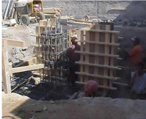
*Figura 3.27 Torre Autosoportada      Cimentación para Torre Autosoportada*
