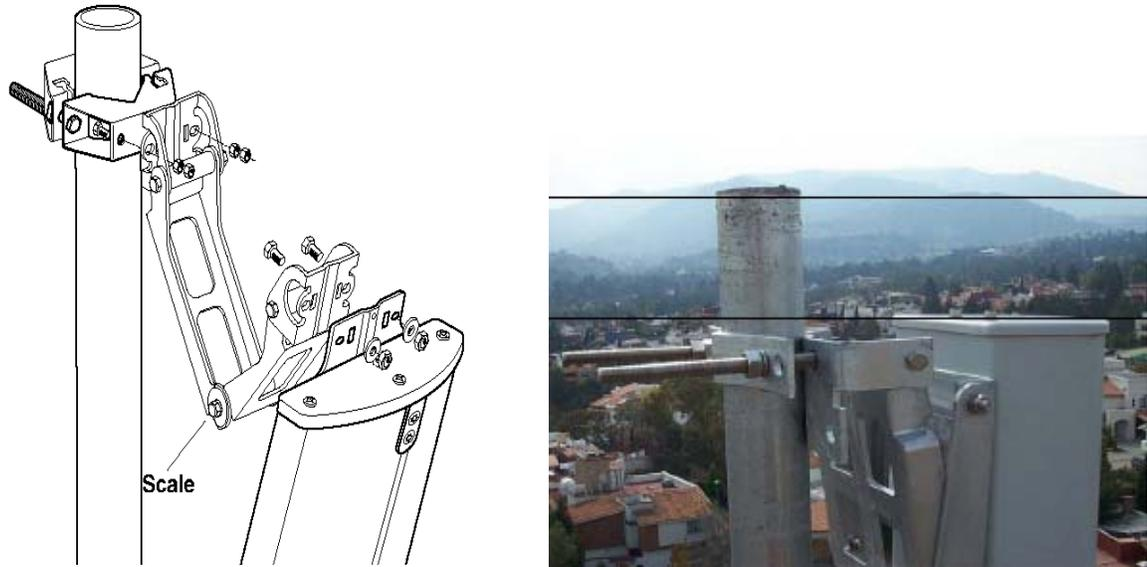
*Figura 3.9 Elementos para un Tilt Mecánico.*
