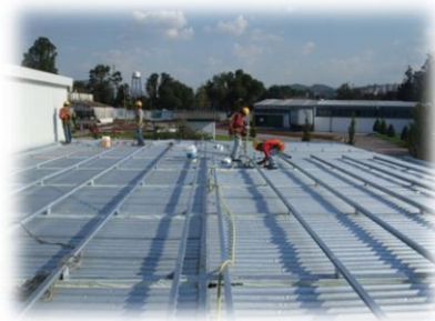
Ilustración 33. Edificios y nave de almacenamiento de cilindros
