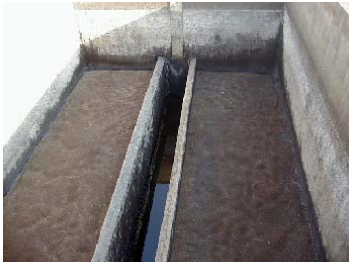
Figura No. 3.2 Lecho de arena del filtro y canaleta
