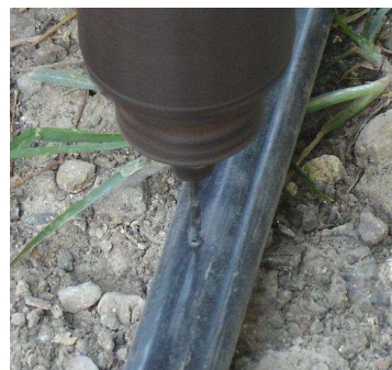
Fig. 4.3 Perforación de las Mangueras. Elaboración Propia
