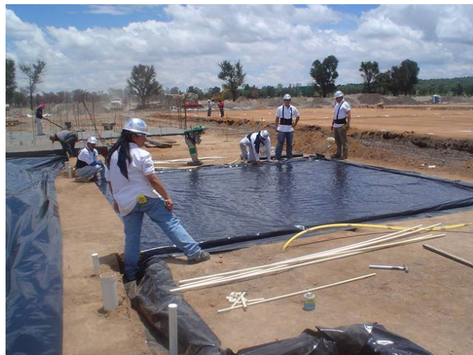
Colocación en el resto de la plataforma
