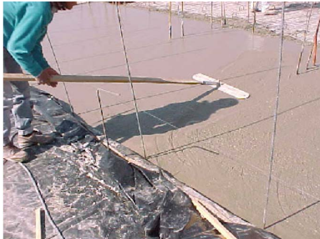
Eliminación de ondulaciones con avión metálico de extensión
