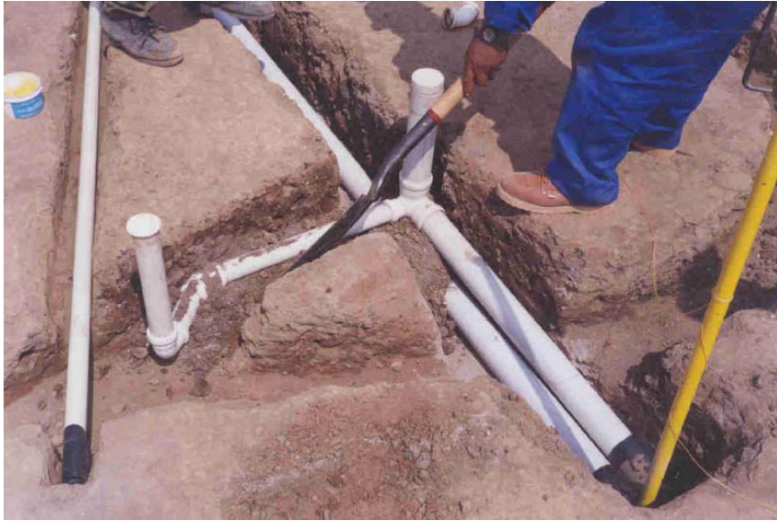
Alojamiento de instalaciones en cepas sobre cama de arena
