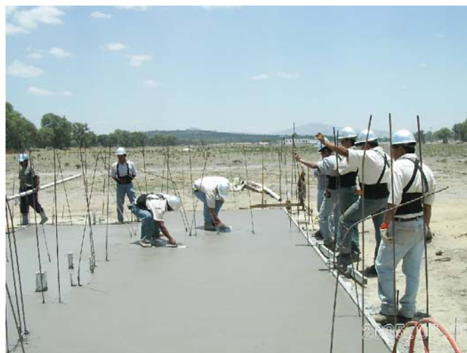
Eliminación de ondulaciones con avión metálico de extensión
