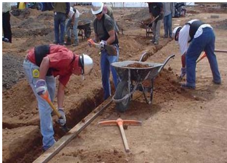
Comenzar a aflojar la tierra con el zapapico.
