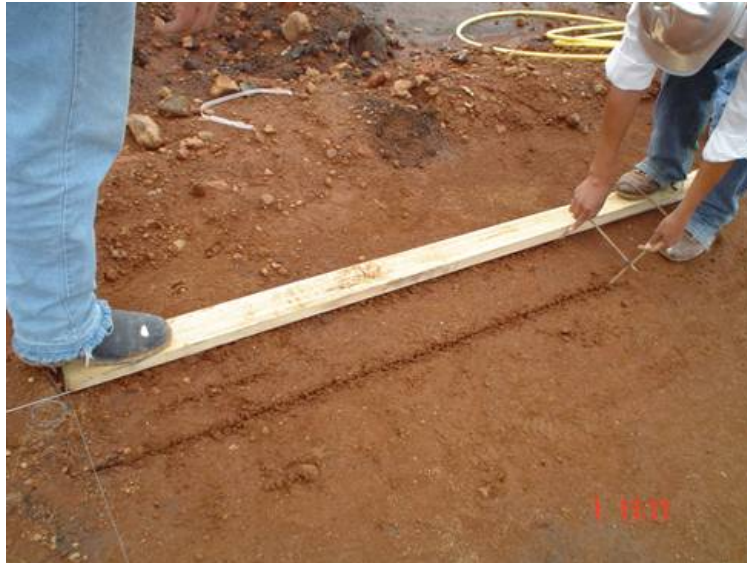
Colocación de reglas
