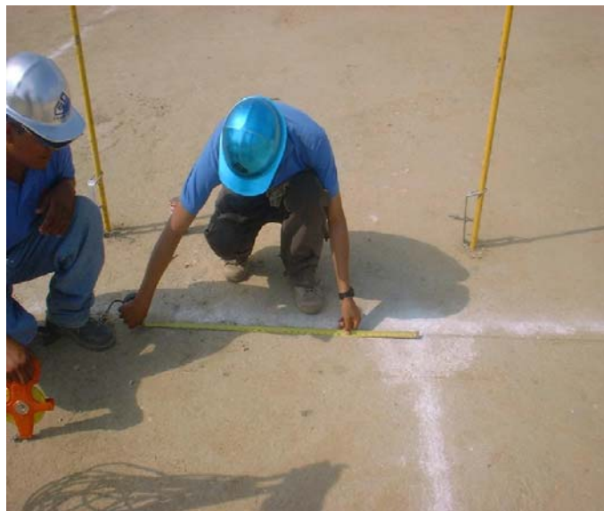
Revisión de escuadra y diagonal
