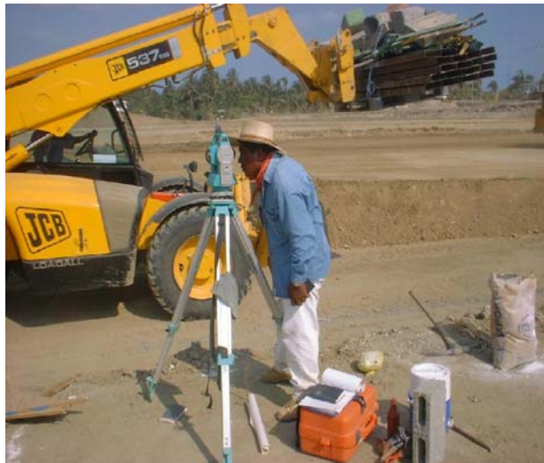
Recepción de puntos para ubicación de ejes
