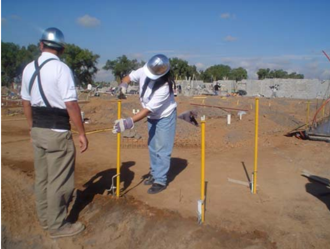
Colocación de piquetas
