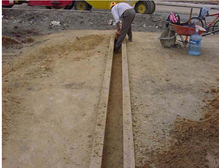
Utilizar reglas como guías de excavación.
