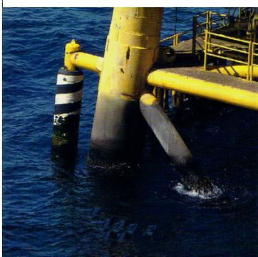
Zona de Mareas y Oleaje. En esta zona, la corrosión suele ser de entre 10 a 20 veces mayor que en aquellas áreas expuestas a la intemperie y de entre 1.5 a 3 veces que en las áreas sumergidas. Los problemas de mantenimiento en estas condiciones severas de corrosión están relacionadas con la dificultad de la aplicación de recubrimientos en las estructuras y materiales utilizados para la construcción de la plataforma.
